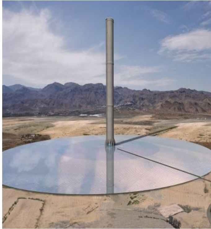
Şekil 1.8. Güneş bacası santrali [13].
