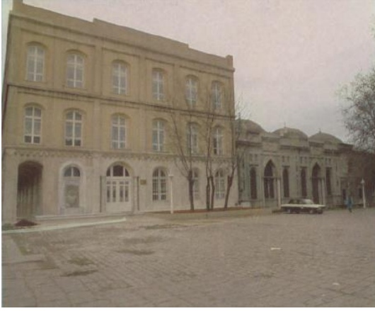
Şekil 4.24. Beyazıt Devlet Kütüphanesi Merkez Binası, Kültür ve Turizm Bakanlığı KYGM, 1988
