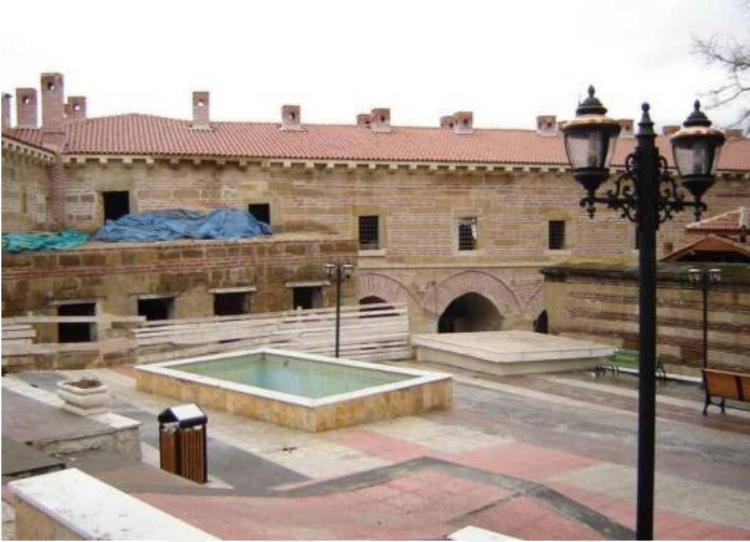
Şekil 2.5. Amasya Merzifon Tarihi Taşhan Binasının Dış Cephesi (Paçacıoğlu, 2013, 34)
