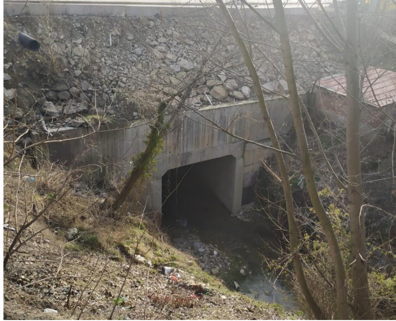
Şekil 2.1. Karabük-Kastamonu Karayolu altında bulunan menfezin memba kesimi.
