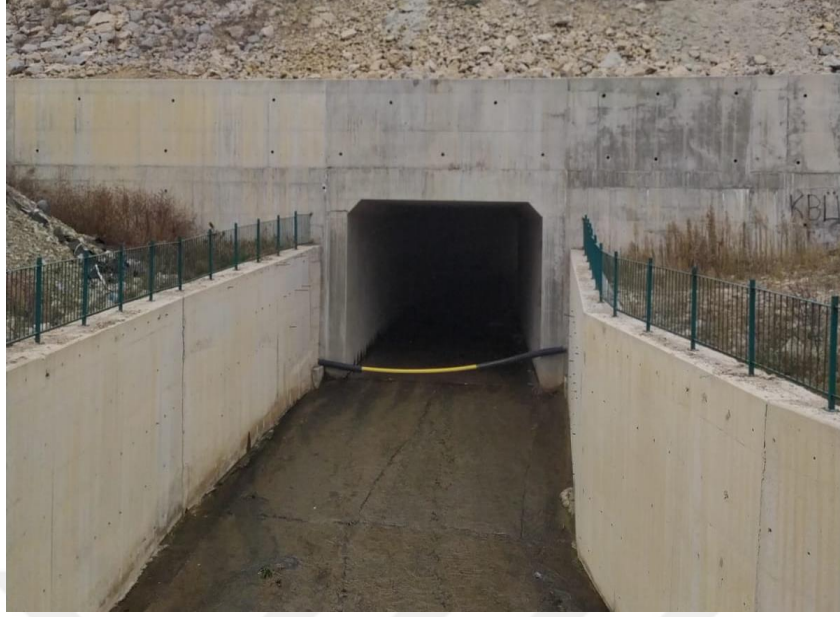
Şekil 1.8. Karabük-Kastamonu Karayolu altında bulunan menfezin mansap tarafı.
