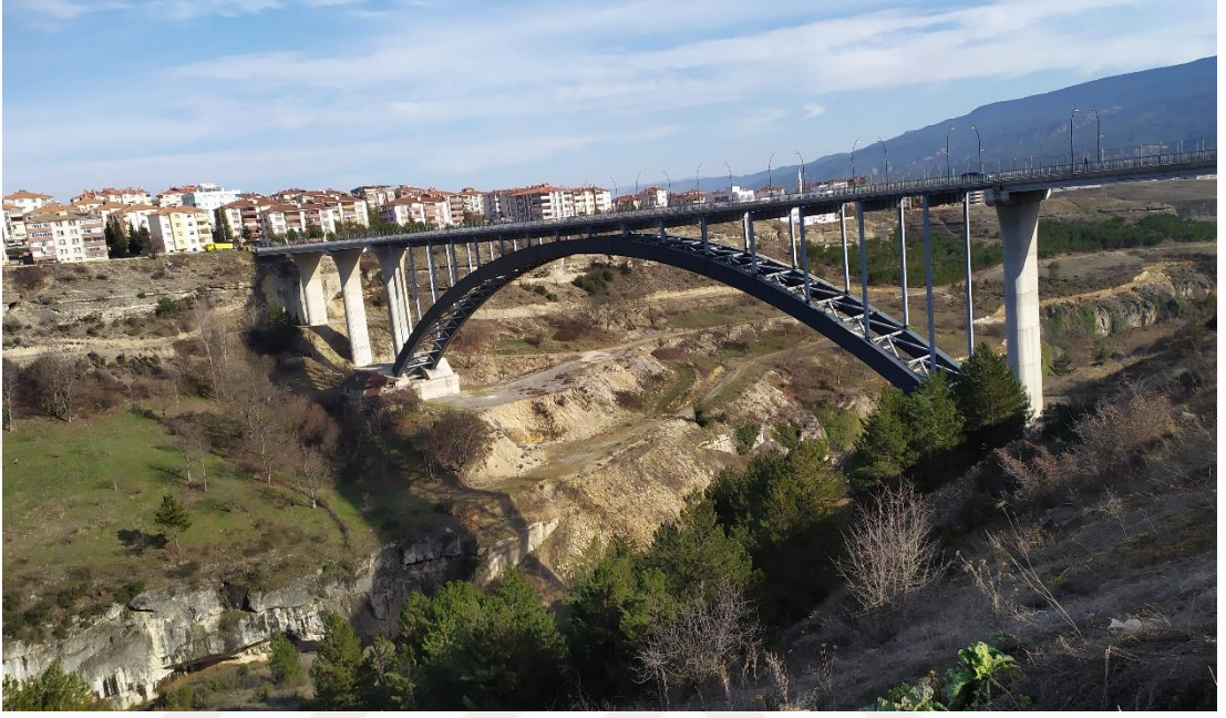
Şekil 2.6. Bulak Kanyonu Köprüsü.
