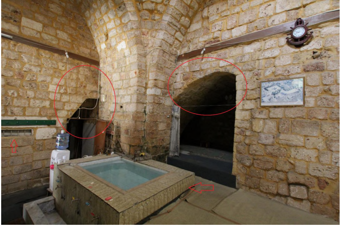
Foto 67. Dilatasyon izlerinden anlaşılacağı üzere sonradan açılan kısımlar
