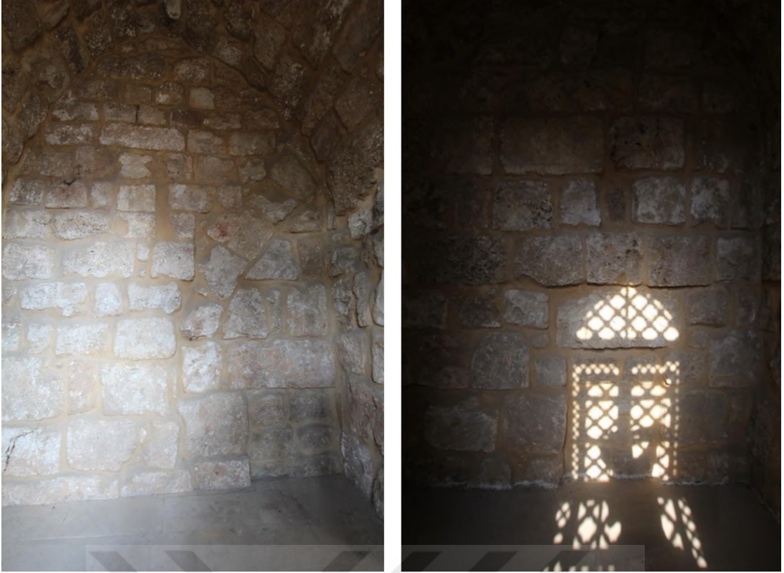
Foto 16-17. Üst katta bulunan odaların doğu duvarında sonradan kapatılan açıklıklar
