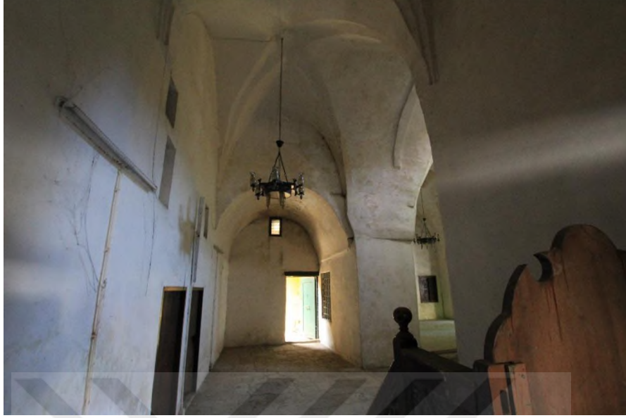
Foto 122. Giriş holü üst örtüsü
