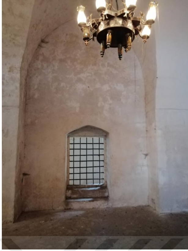
Foto 120. Mescit mekânında pencereye dönüştürülen niş
