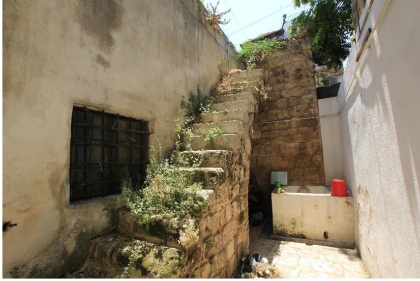
Foto 87. Avlu ve merdivenler
