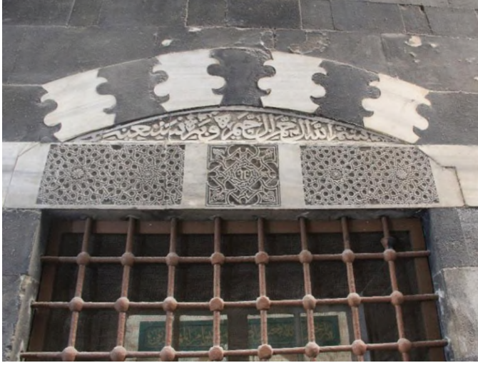
Foto 53. Kartaviyye Medresesi güney cephe pencere detayı
