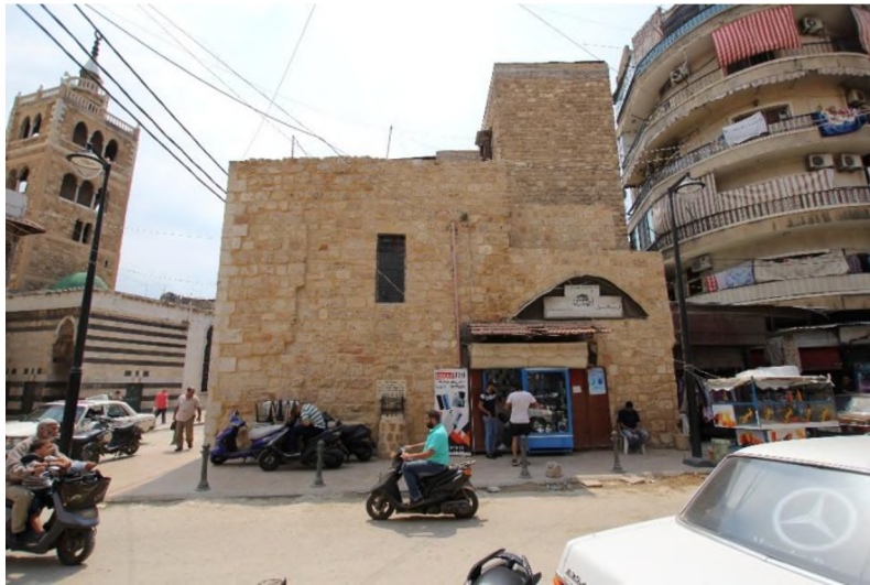
Foto 96. Nasırıyye Medresesi doğu cephe
