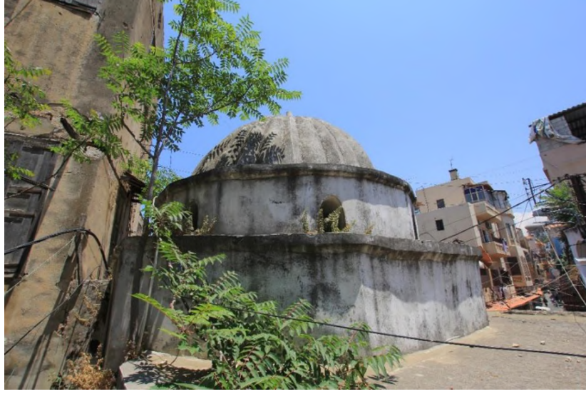
Foto 85. Kubbenin dış görünüşü
