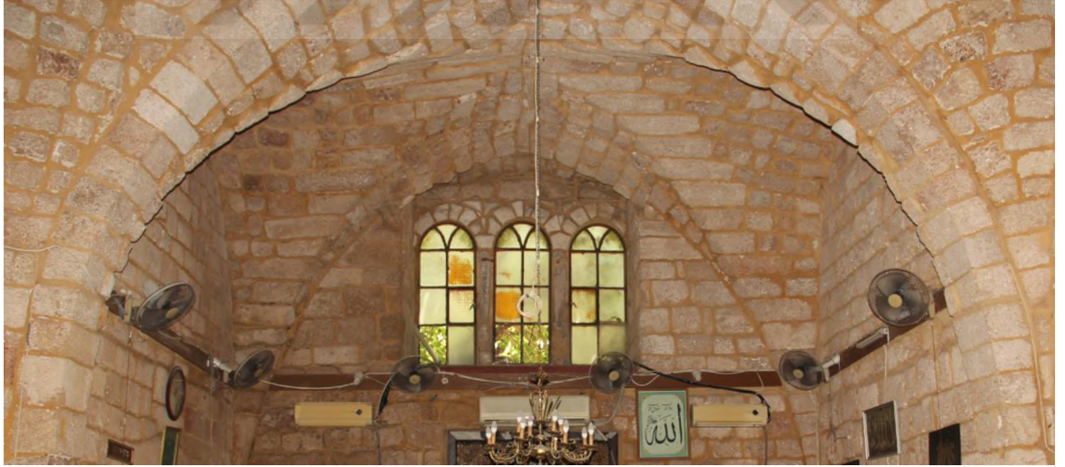
Foto 68. Blok halindeki üç kemerli pencere
