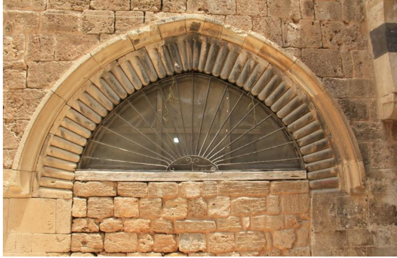
Foto 78. Şemsiyye Medresesi batı cephesinde bulunan dilimli yastık kemer
