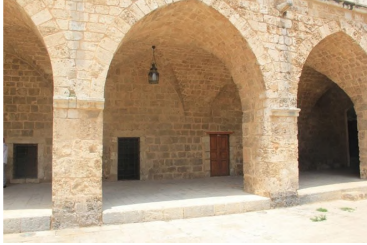
Foto 73. Şemsiyye Medresesi güney cephe ve girişi
