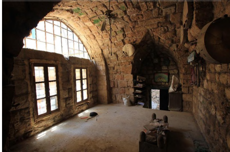
Foto 103. İç mekân güney ve batı cephe
