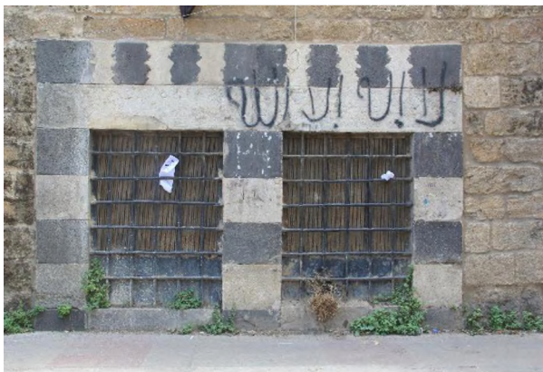
Foto 126. Batı cephe pencere açıklığı
