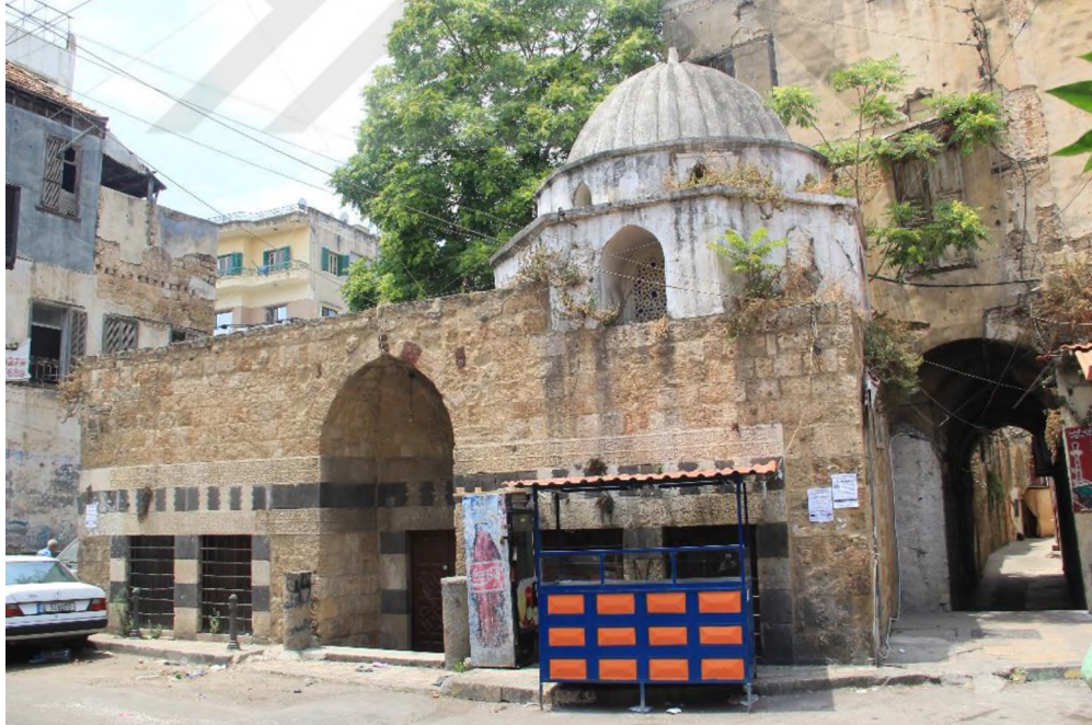
Foto 88. Sükrekiye Medresesi doğu cephe
