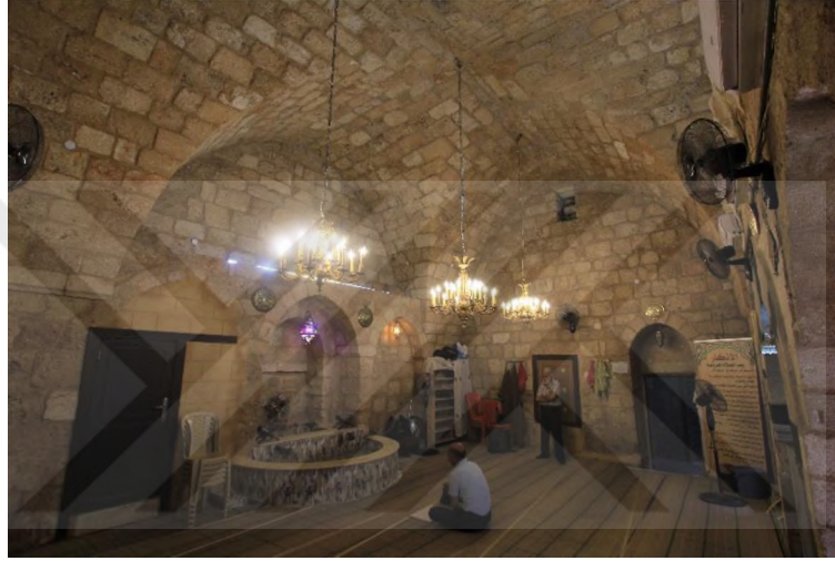
Foto 35. Kuzey ve batı cephe
