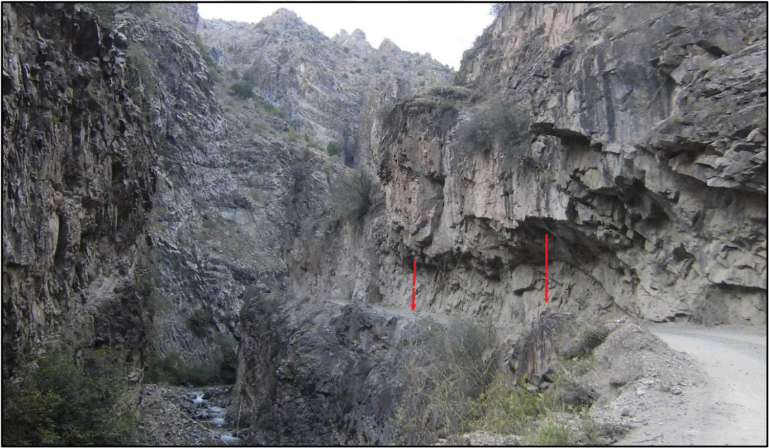
Şekil 4.29. Kaya düşme riski taşıyan Yusufeli-Öğdem Köyü karayolu
