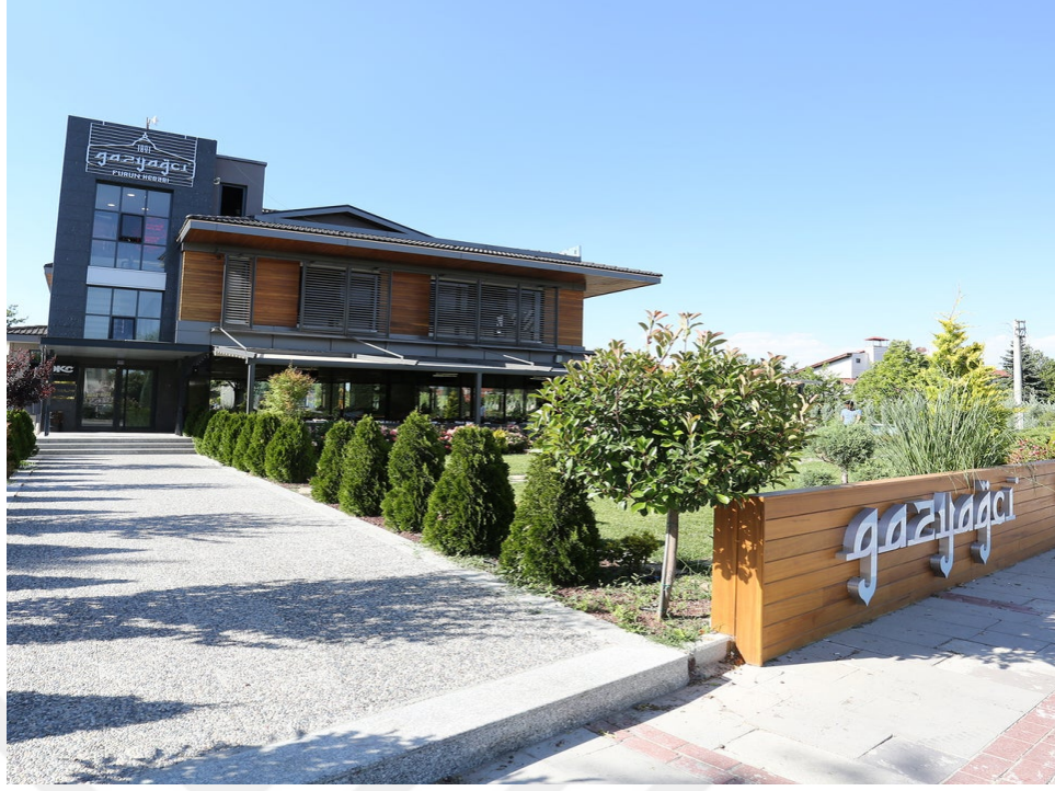
Şekil 52. Gazıyağı Furun Kebapçısı Sol Yan Cephe Görünüm
