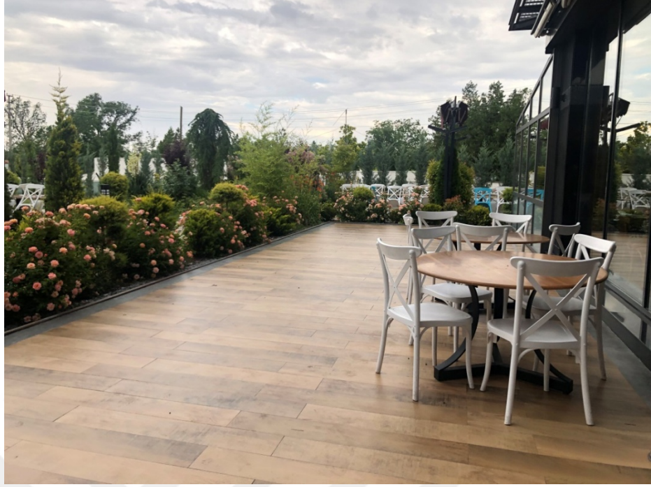
Şekil 60. Gazzyağı Furun Kebapçısı Sağ Yan Cephe Açık Alan
