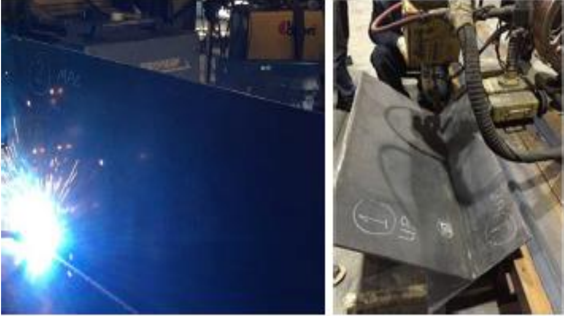
Şekil 6.1. T profillerin kaynatılması işlemi.
