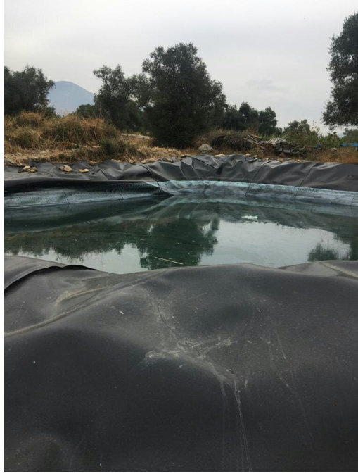
Ėekil 4.5 Ziyaret edilen gnel enerjili pompanın su toplama/depolama blgesi
