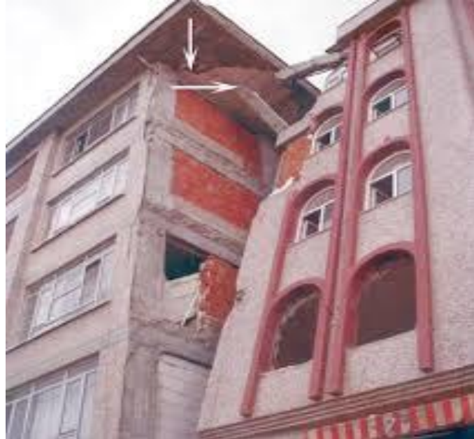
Resim 1.2 Depremde binalar arasında oluşan çekileme etkisi [2]
