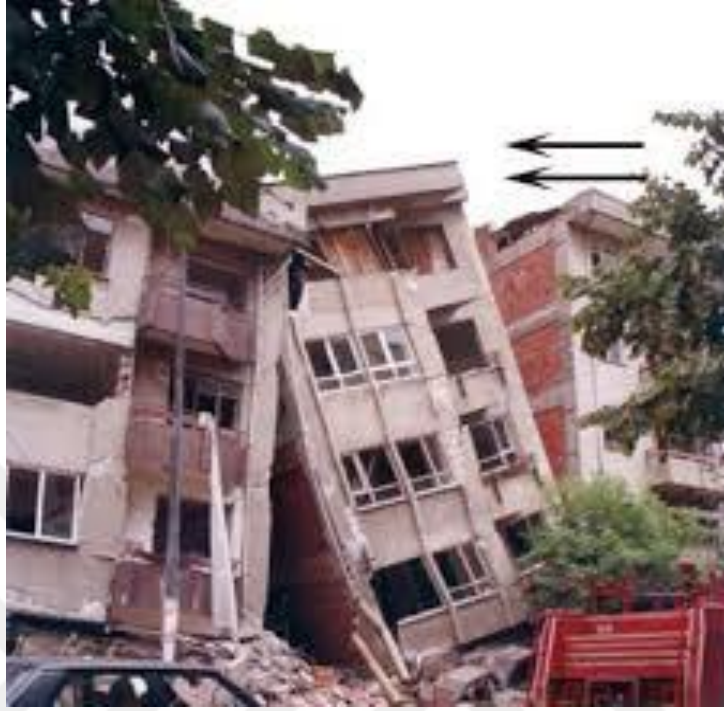
Resim 1.1 17 Ağustos 1999 Marmara depreminde yan binanın çekileme etkisiyle devrilen bina [1]
