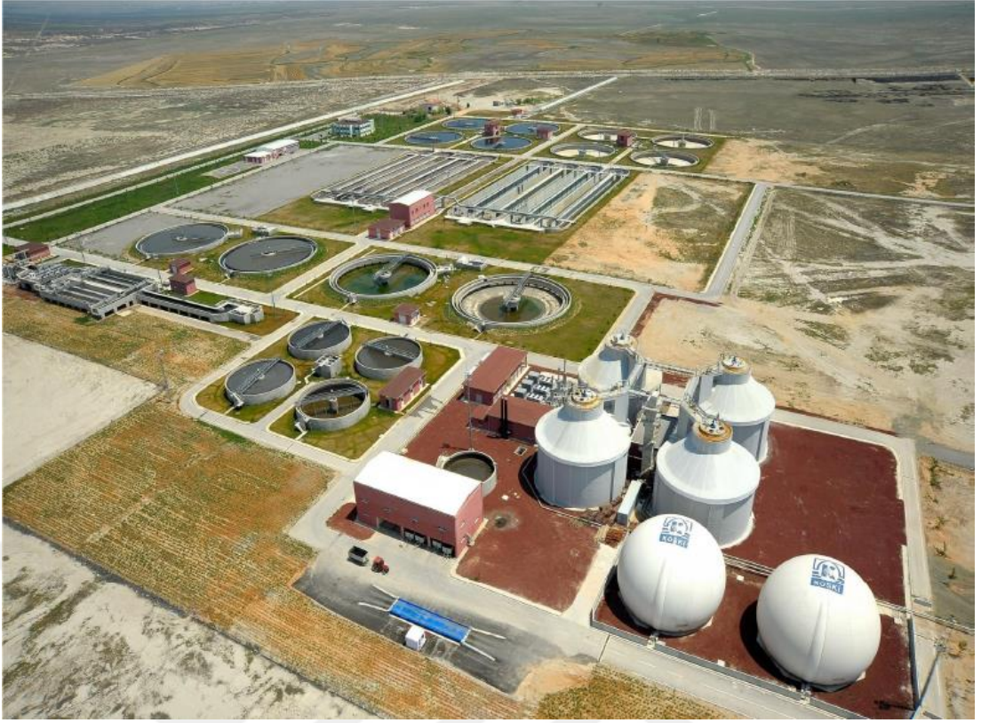
Şekil 3.5. Konya kentsel atıksu arıtma tesisi üstten görünüşü
