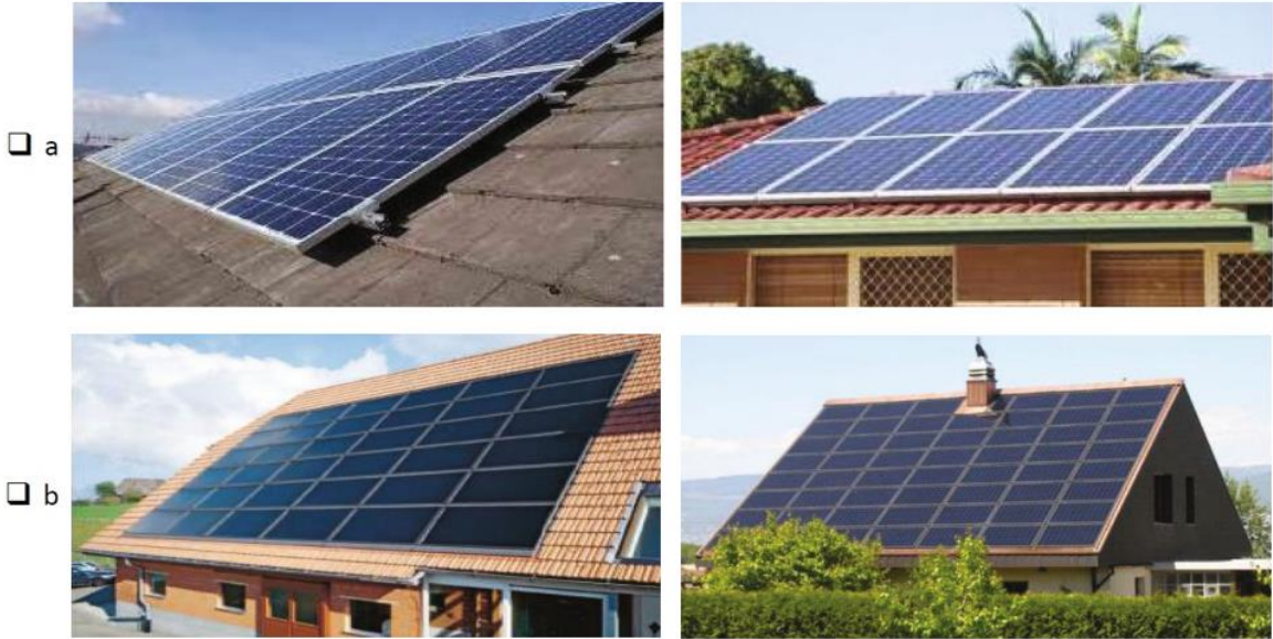
Fig 20: BIPV ve BAPV sistemleri arasındaki farklar
