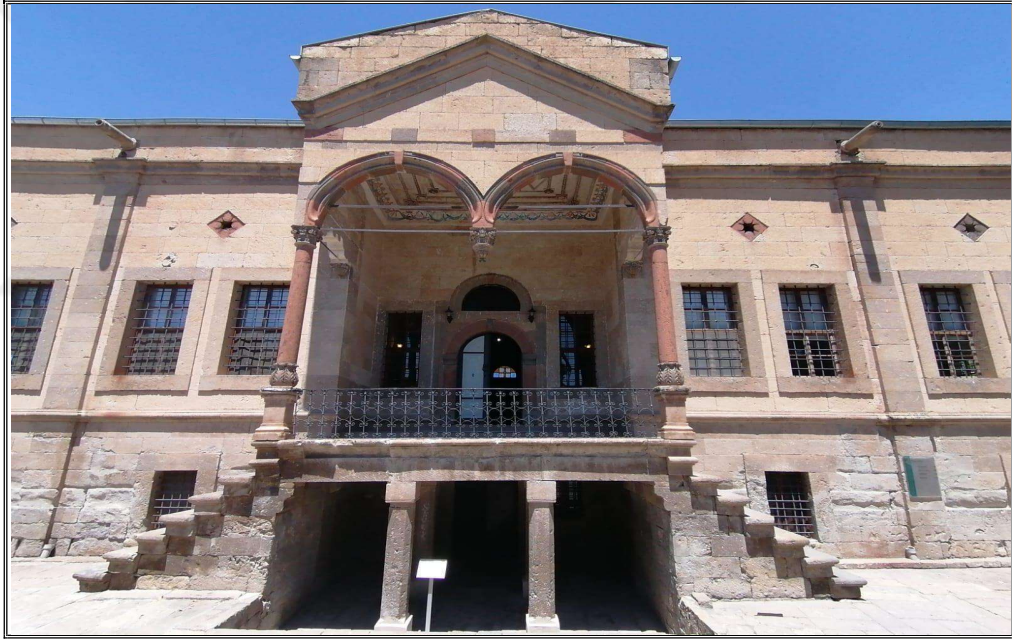
Resim 15. Kapadokya Üniversitesi Rektörlük Binası
