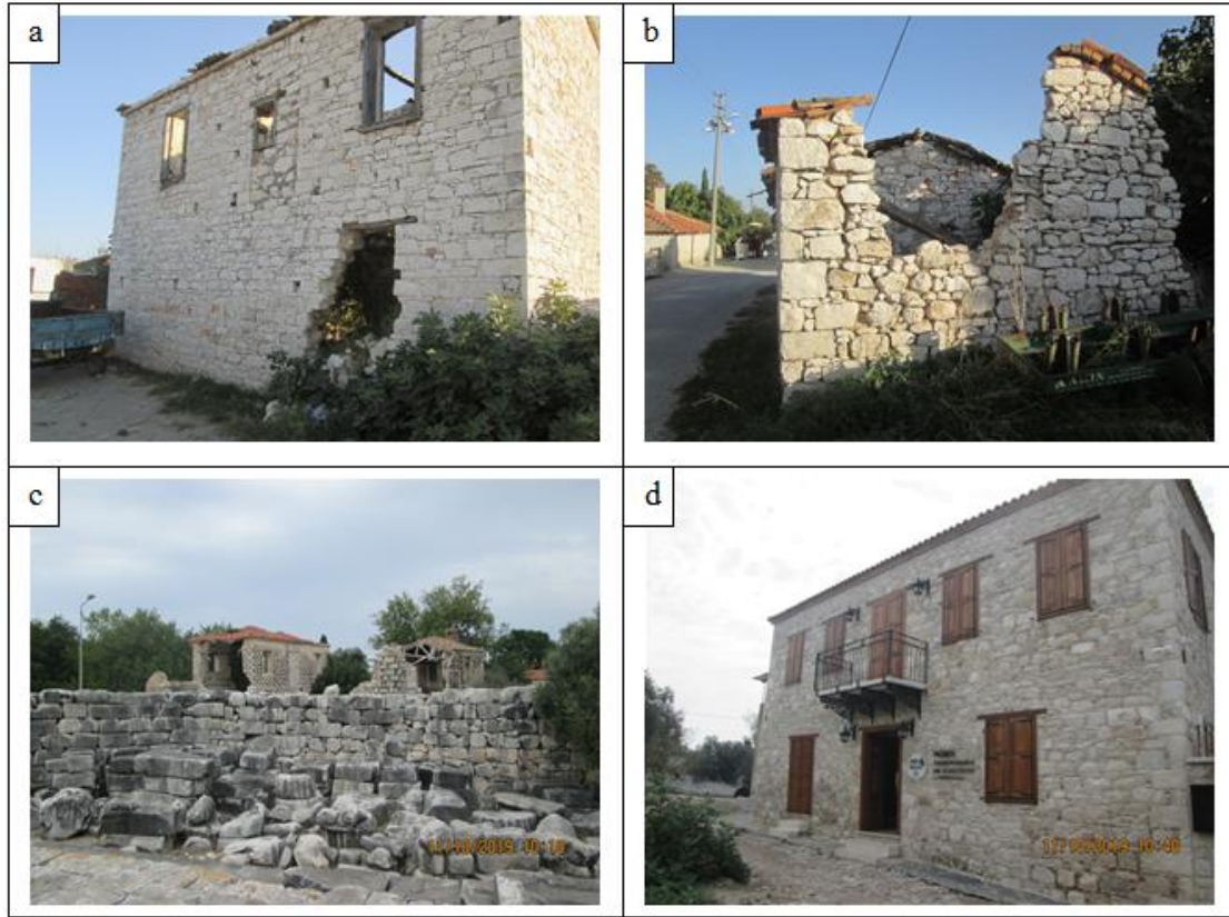
Fotoğraf 26: Akköy ve Hisar Mahallesi’nde Kendi Haline Terk Edilmiş Taş Yapılardan (a, b, c) ve Restore Edilerek Turizme Kazandırılmış Bir Yapıdan (d) Görünüm
