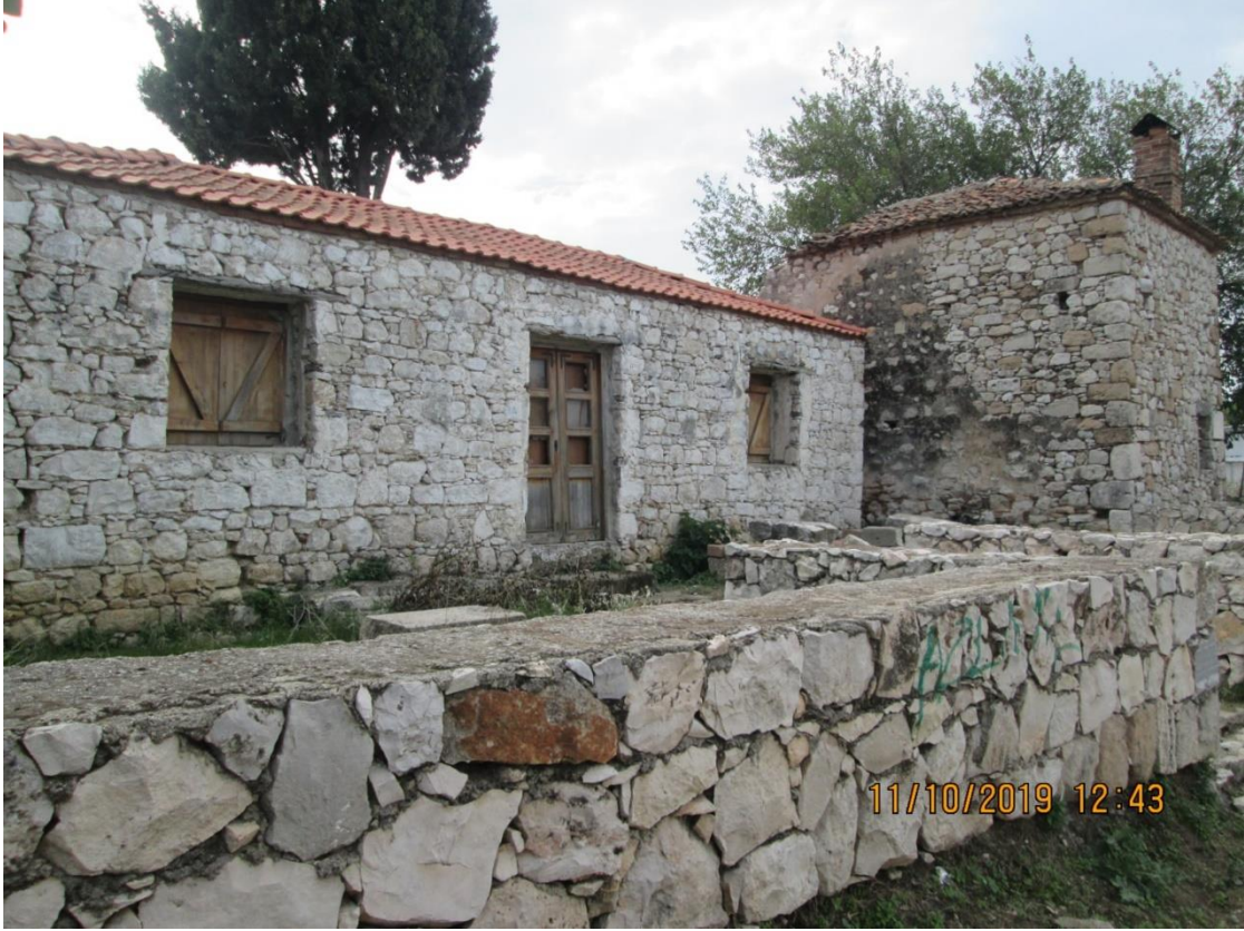
Fotoğraf 24: Taşa Şekil Verilmeden İnşa Edilen Taş Yapılardan Bir Görünüm (Hisar Mahallesi-Eski Yoran Köyü)
