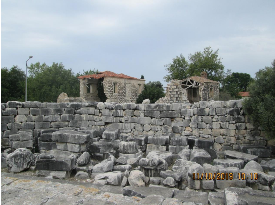
Fotoğraf 41: Hisar Mahalle'sinde Tapınak Yakınındaki Sit Alanında Yıkılmaya Terk Edilen Taş Yapılı Meskenlerden Bir Görünüm
