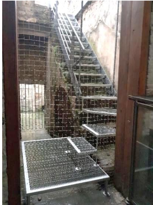
Şekil 2.34. Çağdaş malzeme ile merdiven eki (Kişisel arşiv, 2018)
