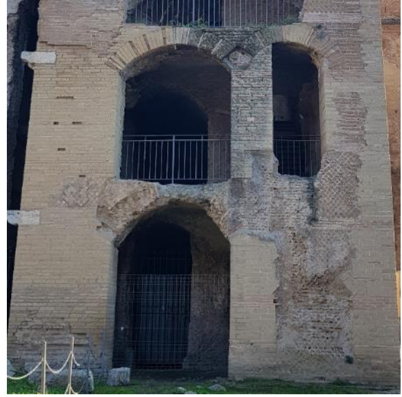
Şekil 2.32. Özgün kemer elemanlarının gösterilmesi için kullanılan metal çerçeve (Kişisel arşiv, 2018).
