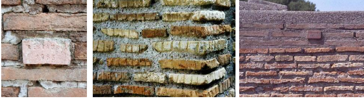
Şekil 2.5. Ostia'daki duvar bütünlemelerinden örnekler (Kişisel arşiv, 2018)
