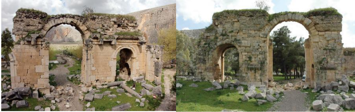
Şekil 3.13. Restorasyon öncesi Zafer takı güney ve kuzey cepheleri (Işık, 2008) [74].
