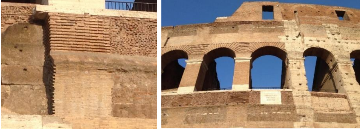
Şekil 2.8. Colosseum cephesinde tuğlaların tırtıklı örülmesi ile duvarın devam ettiğini gösteren bütünlemeler (Kişisel Arşiv, 2018).
