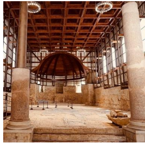
Şekil 2.27. Villa del Casale'nin kaldırılan Minissi tasarımı koruma çatısı [44].
