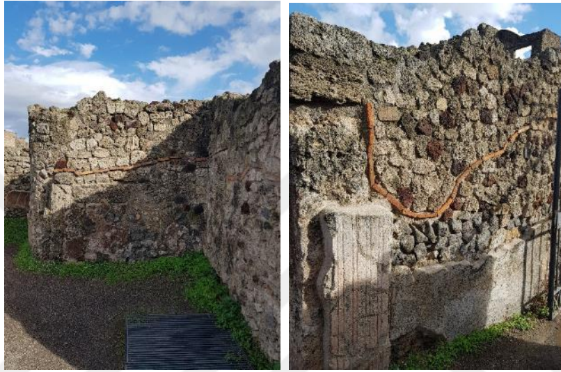
Şekil 2.6. Pompeii Antik Kenti'nde malzeme ayırımını sağlayan tuğla dizileri (Kişisel arşiv, 2018).
