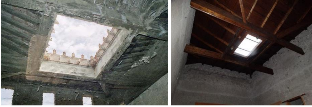
Şekil 2.30. 1960'larda eskisi ile değiştirilen çatı rekonstrüksiyonu, 2001 (Peter Woods).
