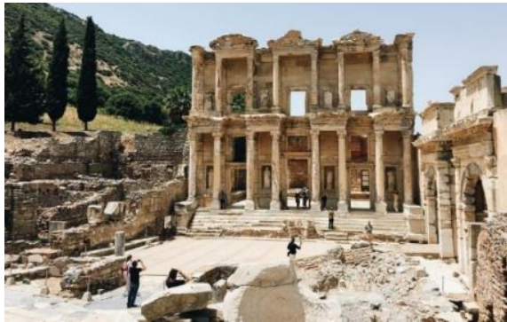
Şekil 2.15. Efes Celsus Kütüphanesi cephe anastilosisi (Kişisel arşiv, 2014).
