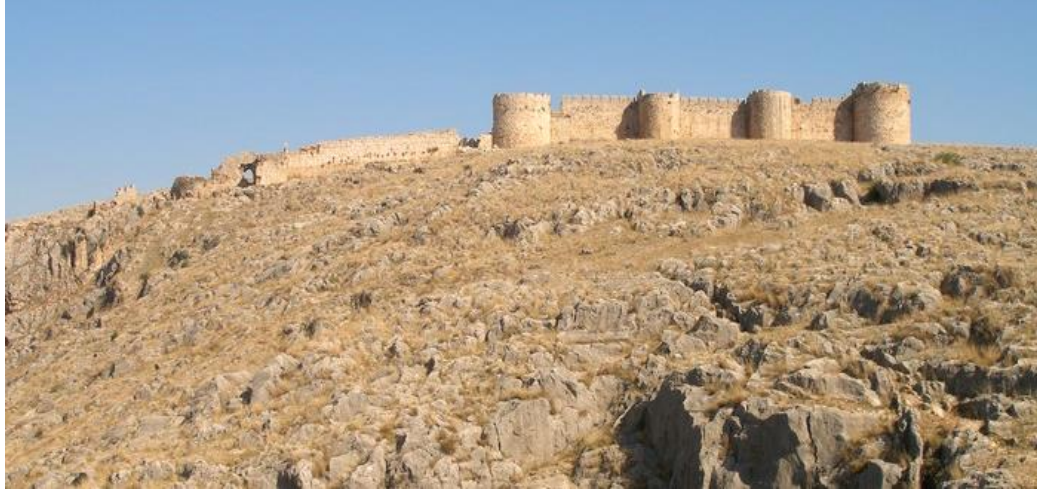
Şekil 3.24. Anavarza Kalesi giriş kapısı, güney kuleleri ve suru, güneydoğu kulesi (Kişisel arşiv, 2020)
