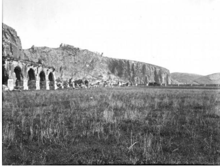
Şekil 3.9. Anavarza Genel Görünüm (Bell, 1905) [67].
