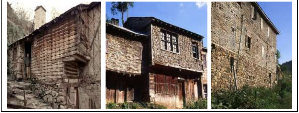
Şekil 8. Bağdadi ile yapılmış “çakatura” sistemler (M. R. Sümerkan, Arşiv)
