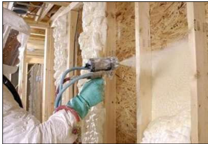
Şekil 65. Poliüretan köpük uygulaması (PUR) (URL-31)
