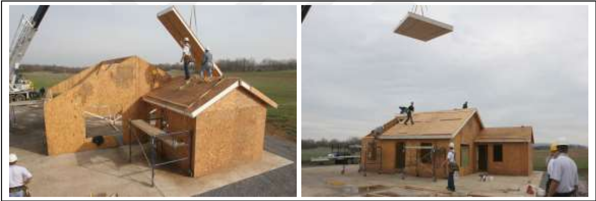
Şekil 10. Ahşap panel sistem yapı örneği (URL-2)
