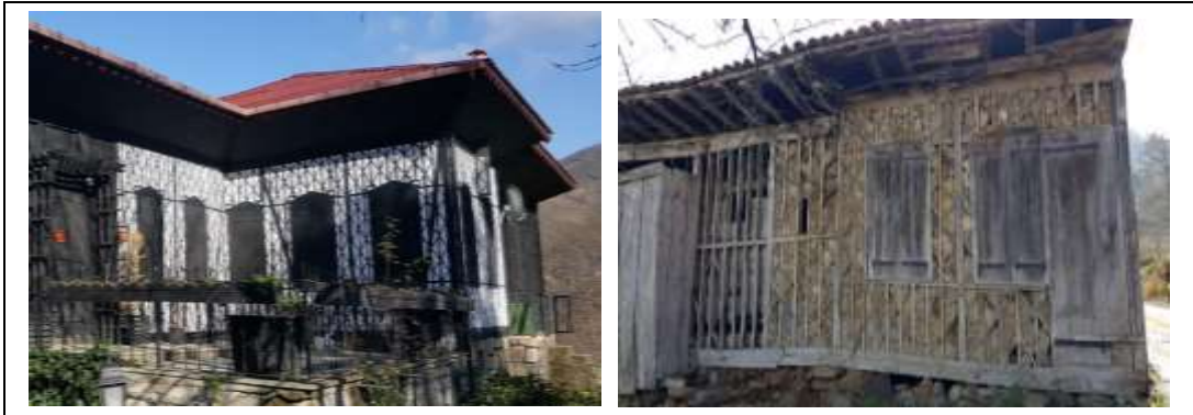
Şekil 7. Muskalı dolma tekniğiyle yapılan yapı örneği (E. Lakot Alemdağ, Arşiv)
