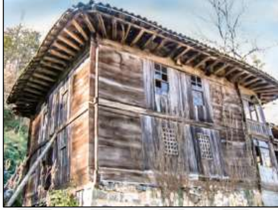
Şekil 4. Ahşap yığma sistemle inşa edilmiş bir yapı (Güler ve Bilge, 2013)
