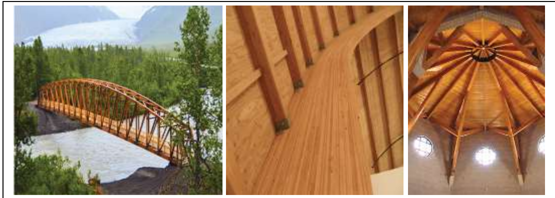
Şekil 16. Glulam ile yapılmış köprü ve kavisli çatı (APA, 2017)
