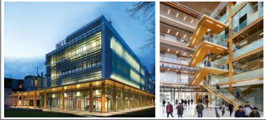
Şekil 33. Yeryüzü Bilimleri binası, Kanada (URL-9)
