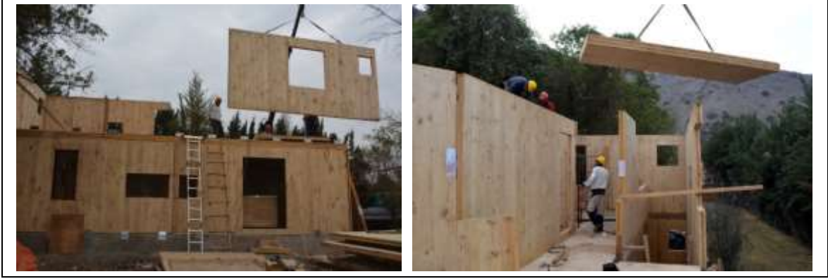
Şekil 27. CLT binasının yerinde uygulanması ve montaj işlemi (Lukacs vd., 2019)
