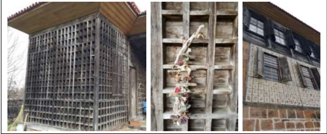
Şekil 6. Göz dolma tekniğiyle yapılan yapı örneği (E. Lakot Alemdağ, Arşiv)
