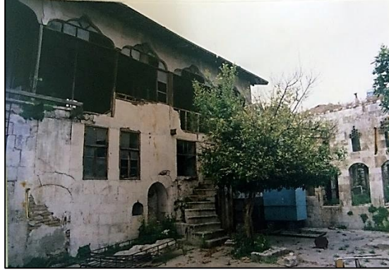
Geleneksel Avlulu Ev (1339 Parsel) Avlu
