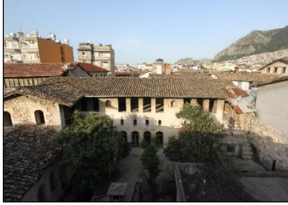
Geleneksel Avlulu Ev (485 Parsel) Avlu
