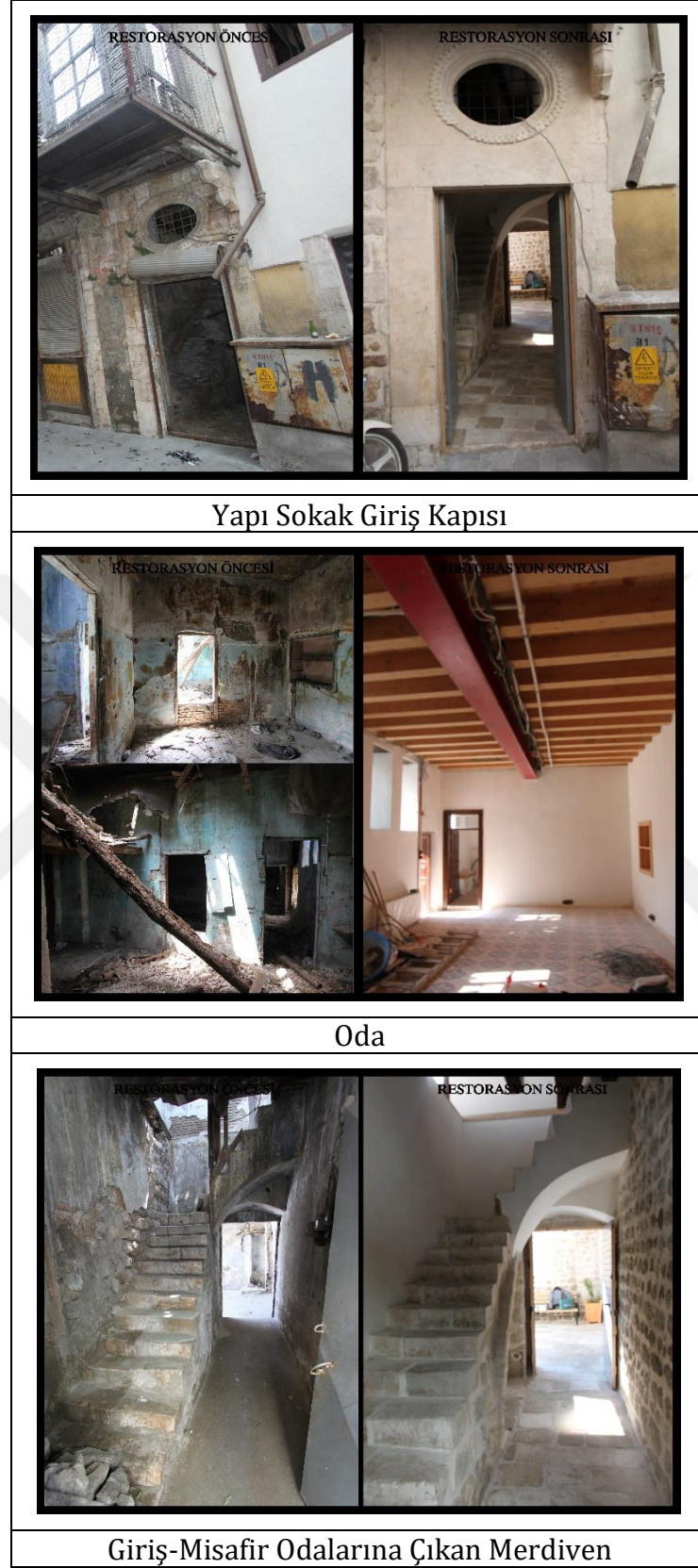
Şekil 3.68 Geleneksel avlulu ev (1339 Parsel) restorasyon öncesi ve sonrası (HBB KUDEP)
