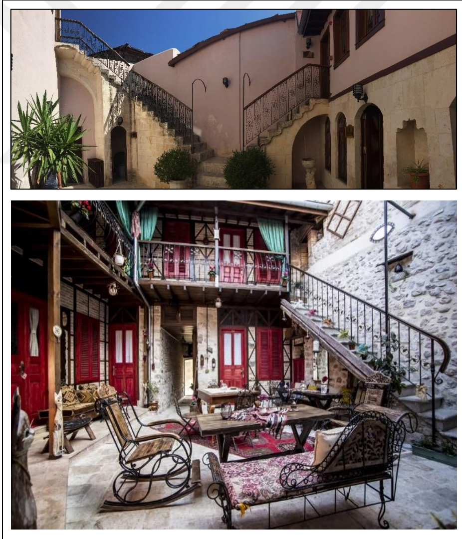
Şekil 3.45 Avluda bulunan merdiven korkulukları örnekleri (Kavinn Butik Otel)
