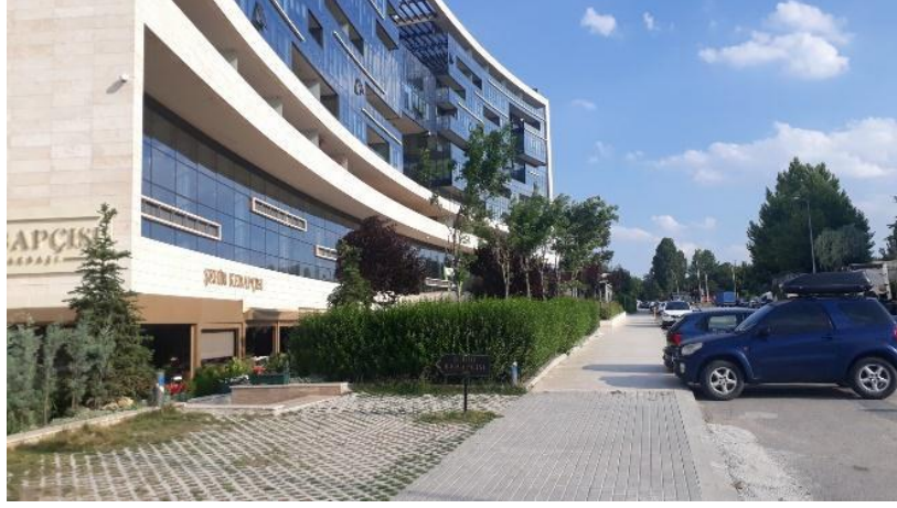
Şekil 4.6 Via Green Yeşil Bina Açık Izgara Döşeme Sisteminin Kullanılması
