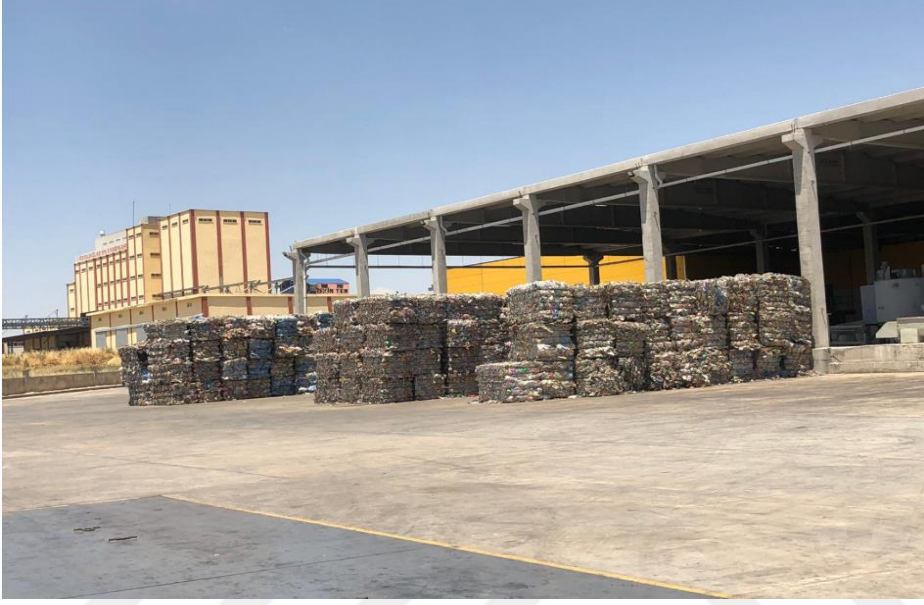
Şekil 2.4: Katı Atık Tesisinde Atıkların İstiflenmesi (I)
