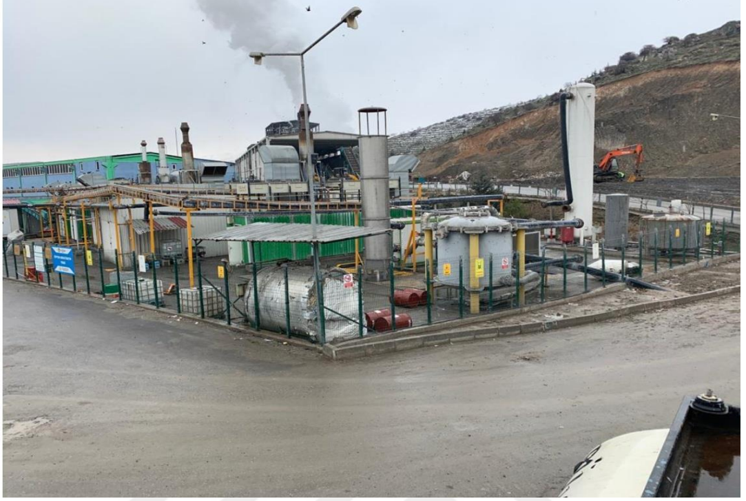
Şekil 3.10: Katı Atık Tesisinin Genel Görünümü (II)
