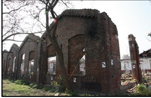
Şekil 5.28. T2 binası cephe görünüş (Özgüven, 2016b)
