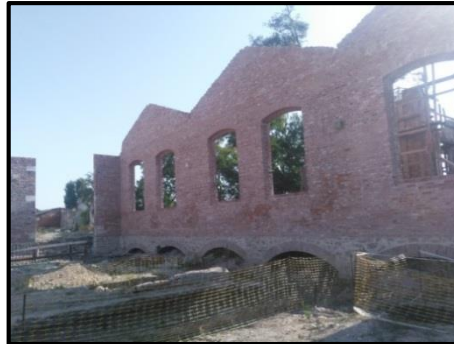
Şekil 5.26. T2 binası kemerli yığma + harman tuğla duvar (Özdemir, 2019)
