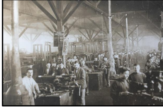
Şekil 4.2. Eskişehir cer atölyesi – İç mekan görünüş (TÜRASAŞ, 2020a)
