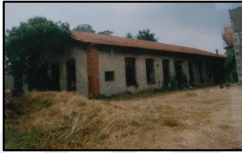
Şekil 5.17. T1 binası yan görünüş (İstanbul I numaralı yenileme alanları kültür varlıklarının koruma bölge kurulu, 2008)
