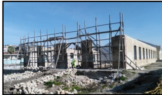
Şekil 5.45. T3 binası yıkılan duvarların tamamlanması (Özdemir, 2019)
