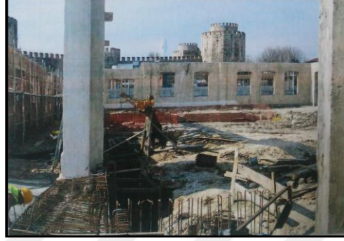
Şekil 5.19. T1 iç kısım kuyu temel çalışması (İstanbul I numaralı yenileme alanları kültür varlıklarını koruma bölge kurulu, 2018)
