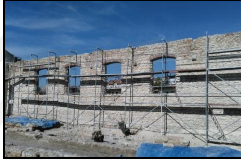
Şekil 5.38. T3 binası iç cephe görünüş (Özdemir, 2019)
