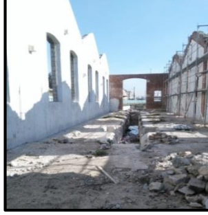
Şekil 5.24. T2 binası beton tren çukur ve çevresi (Özdemir, 2019)
