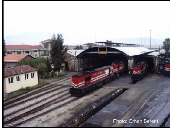
Şekil 4.39. Halkapınar lokomotif deposu dizel deposu görünüş (Berent, 2005b)
