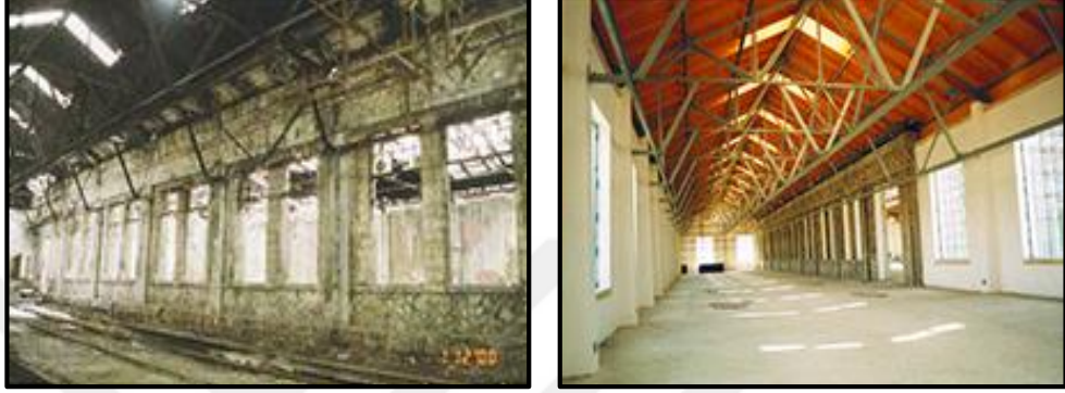
Şekil 4.25. Hangar yapısı iç mekan restorasyon öncesi ve sonrası (cermodern, 2020)
