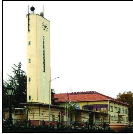
Şekil 4.7. Tülomsaş yerleşkesi - giriş kapısı (Özkut ve Özaslan, 2009)
