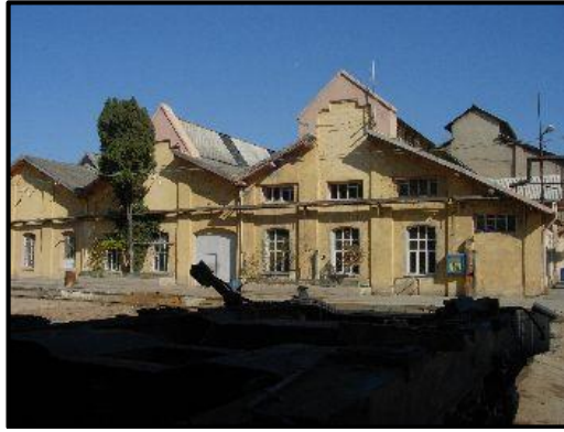
őekil 4.6. Eskiőehir cer at lyesi –  retim binaları ( zkut ve  zaslan, 2009)
