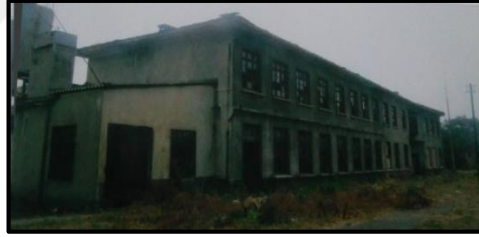
Şekil 5.50. T6 binası görünüşü (İstanbul I numaralı yenileme alanları kültür varlıklarını koruma bölge kurulu, 2008)
