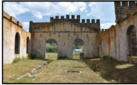
Şekil 4.19. Sarıkamış cer atölyeleri iç cephe görünüş (Doğan, 2019)
