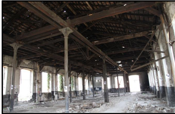
Şekil 5.15. T1 binası iç mekan çatı görünüşü ve çelik destek (Özgüven, 2016b)
