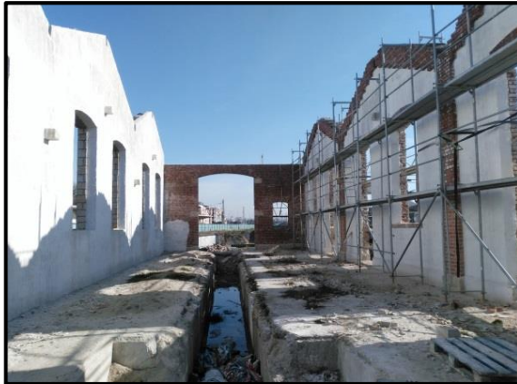
Şekil 5.12. T2 binası beton zemin döşemesi (Özdemir, 2019)
