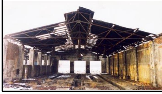
Şekil 4.23. Betonarme kolon - çelik çatı (Sezer, 2013)
