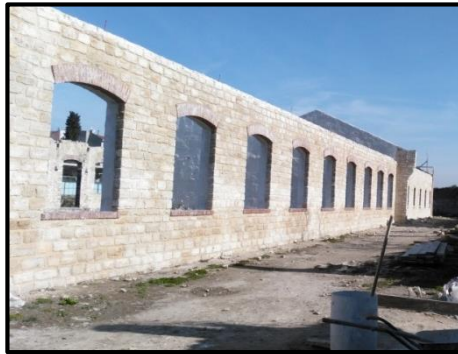
Şekil 5.39. T3 binası pencere açıklıkları (Özdemir, 2019)
