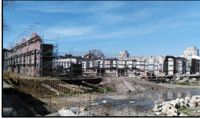
Şekil 5.33. T2 binası yıkılan duvarların tamamlanması (Özdemir, 2019)
