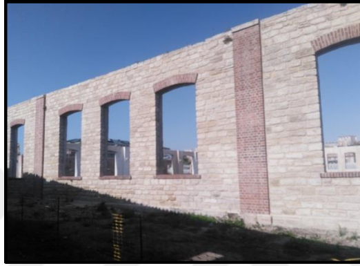
Şekil 5.14. T1 binası yan cephe görünüş (Özdemir, 2019)
