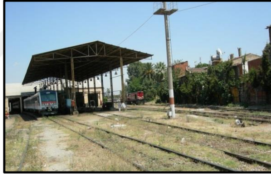
Şekil 4.38. Halkapınar lokomotif deposu görünüş (Berent, 2005a)
