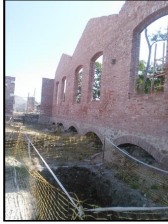
Şekil 5.27. T2 binası kemerli yığma duvar + harman tuğla duvar ve kazı çalışması (Özdemir, 2019)
