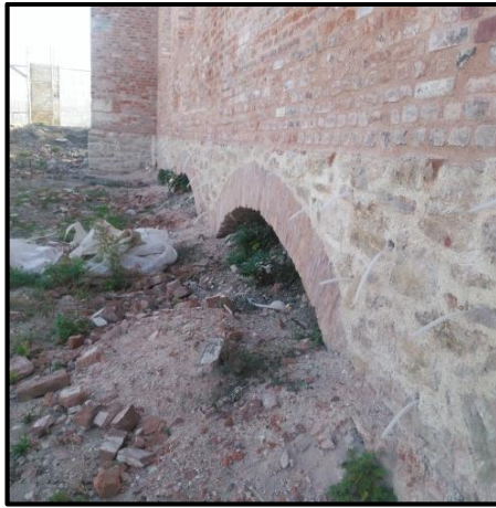
Şekil 5.34. 2019 Duvarların sağlamlaştırılması (Özdemir, 2019)
