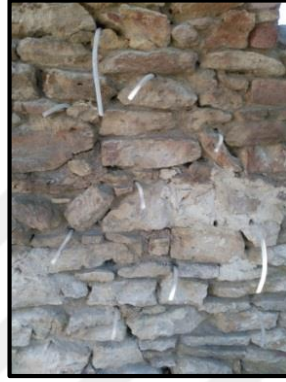
Şekil 5.47. Duvarların sağlamlaştırılma uygulamasından (Özdemir, 2019)
