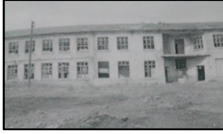
Şekil 5.52. T6 binası giriş cephesi görünüş (İstanbul II numaralı yenileme alanları kültür varlıklarını koruma bölge kurulu, 2015)
