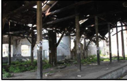
Şekil 5.41. T3 binası ahşap çatı ve dikme (Özgüven, 2016b)
