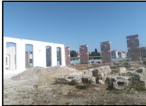
Şekil 5.31. T2 Binası temel çalışmasında çıkan kalıntılar (Özdemir, 2019)
