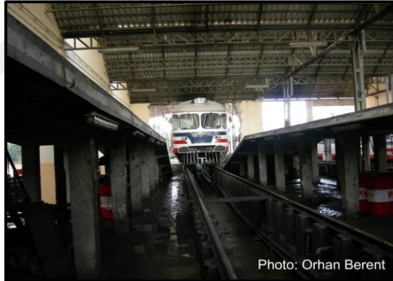
Şekil 4.40. Halkapınar lokomotif deposu iç mekan görünüş (Berent, 2005a)
