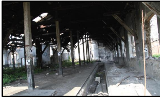
Şekil 5.36. T3 binası zemin döşemesi (Özgüven, 2016b)
