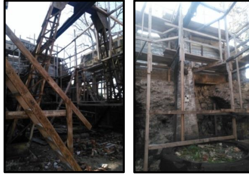
Şekil 4.12. Bondaj ve tav ocağı iç mekan görünüş (Özdemir , 2019)
