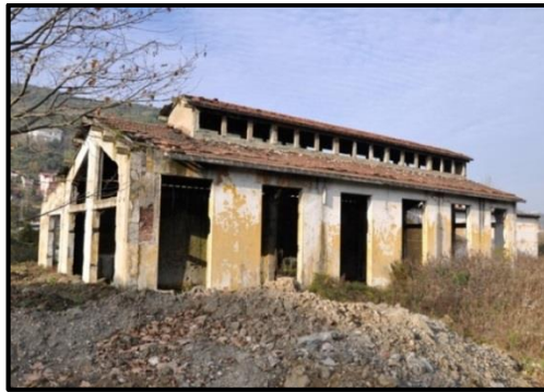
Şekil 4.46. Lokomotif bakım ve onarım atölyesi görünüş (Tokel, 2018)
