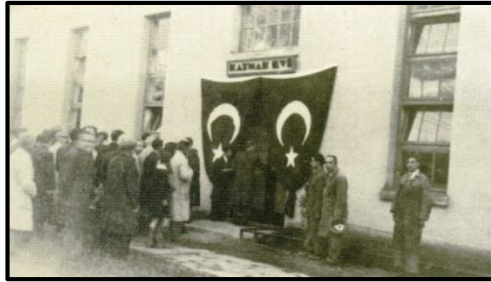
Şekil 4.4. Eskişehir Cer Atölyesi – Kaynakevi (TÜRASAŞ, 2020a)
