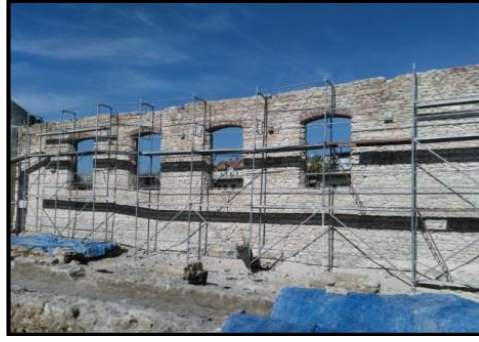
Şekil 5.46. Duvarların sağlamlaştırılması (Özdemir, 2019)
