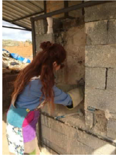
Görsel 86: Fırın Kapısındaki Çamurları Açma Aşaması
