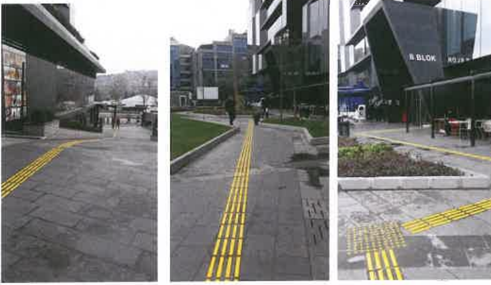
Resim 12: Evrensel Tasarım Yaklaşımı Cafe ve Restaurant Erişiminde Duyumsanabilir Yüzey ve Eşit Yaklaşım (Kendi Arşivim)
