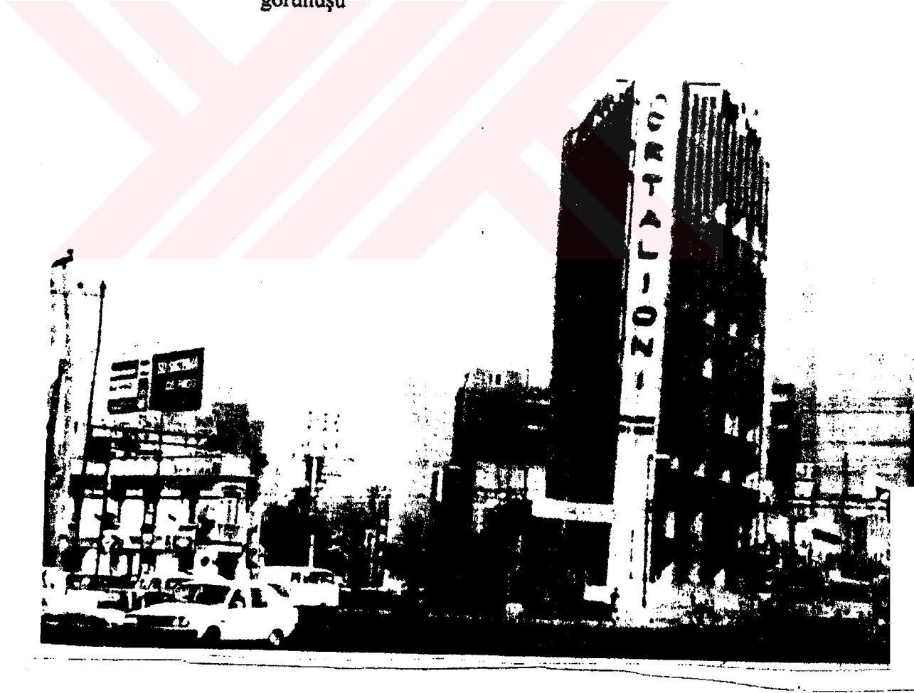
Şekil 2.16 Burulma etkilerine açık üçgene benzer planlı bina planı ve görünüşü
