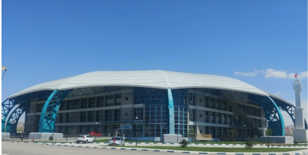
Foto 12: Kampüs içerisinde yer alan spor kompleksi.
