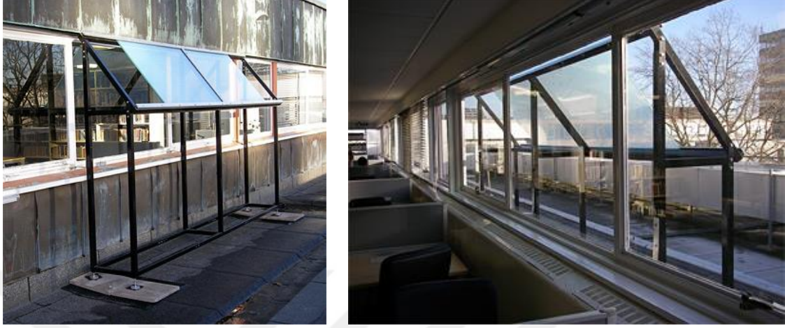
Şekil 14. HOE’li zenithal ışık yönlendirici cam uygulama örneği
