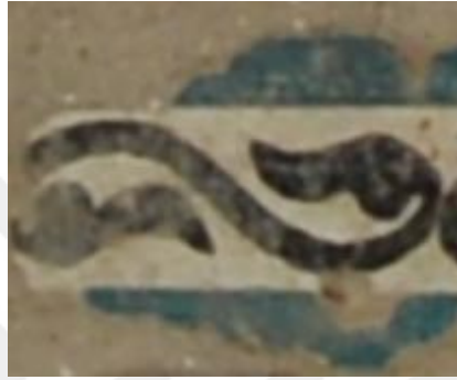
Resim 5. 35. Trbe eyvan, doęu duvar, 5 ve 9 no. lu iniler, birim malzeme kaybı.
