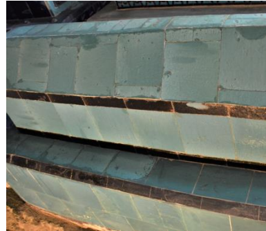
Resim 5. 409. Türbe, üçüncü sanduka, gövde alt taraf, parça kaybı.
