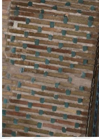
Resim 5. 503. Medrese, batı eyvan sivri kemer, karın üst kısmı, parça kaybı.
