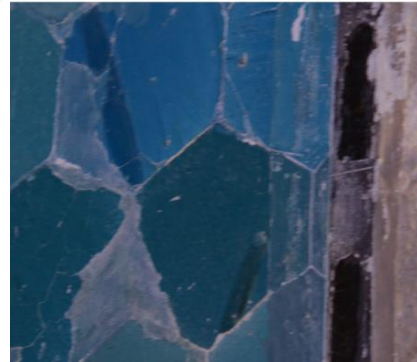
Resim 5. 390. Türbe kuzey duvar, sağ pano alt sıra, yüzeyde boya ayrılmaları ve kayıpları. Resim 5. 391. Türbe, batı duvar, sol pano kapı yanı, yüzeyde boya ayrılmaları ve kayıpları.
