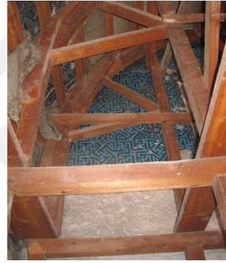
Resim 5. 617. Medrese, güney eyvan, çinileri koruma iskelesi, 2006(V.B.M.). Resim 5. 618. Medrese, güney eyvan çinileri koruma iskele detay, 2006 (V.B.M.).
