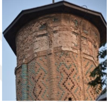
Resim 5. 457. Medrese, minare kuzey-batı cephe, birim malzeme kaybı.
