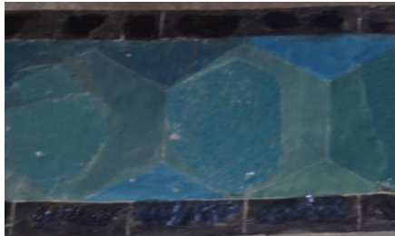
Resim 5. 384. Tübe, batı duvar, kapı üstü, parça kaybı.
