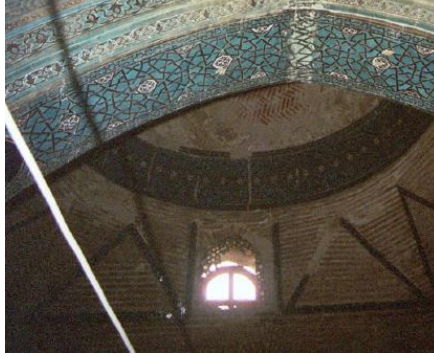
Resim 5. 392. Türbe, Türk üçgeni, birim malzeme kaybı, (V.B.M.).
