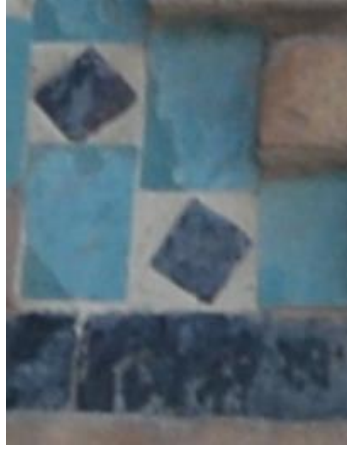
Resim 5. 189. Taç kapı, doğu kenar, düğümlü pano, birim malzeme kaybı.
