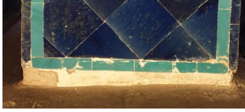
Resim 5. 417 Trbe, ikinci sanduka bař taraf, para kaybı. Resim 5. 418 Trbe, nc sanduka gney taraf, para kaybı.
