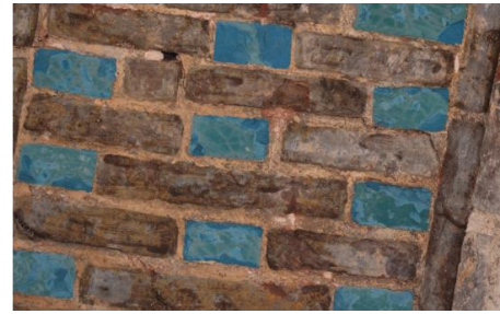
Resim 5. 150. Mescit, kuzey tonoz tepe kuşak, parça kaybı.
