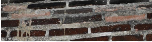
Resim 5. 61. Medrese, Türk üçgenleri, doğu cephe, aşınma-ufalanma.
