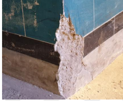
Resim 5. 419. Trbe, beřinci sanduka ayak taraf sol kře, para kaybı.
