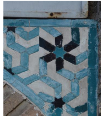
Resim 5. 573. Mescit, doğu cephe, pencere köşelik, sol (güney) taraf, birim malzeme kaybı.
