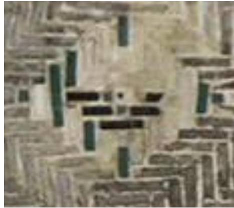
Resim 5. 587. Mescit, tonoz göbeği, birim malzeme kaybı (V.B.M.).
