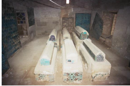
Resim 5. 374. Türbe, kuzey-güney-batı duvarlar, pano bağlantı/taşıyıcı sorunları.
