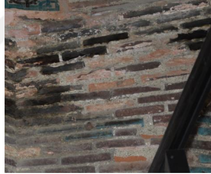
Resim 5. 67. T rbe, T rk   genleri, g ney-batı cephe, par a kaybı.
