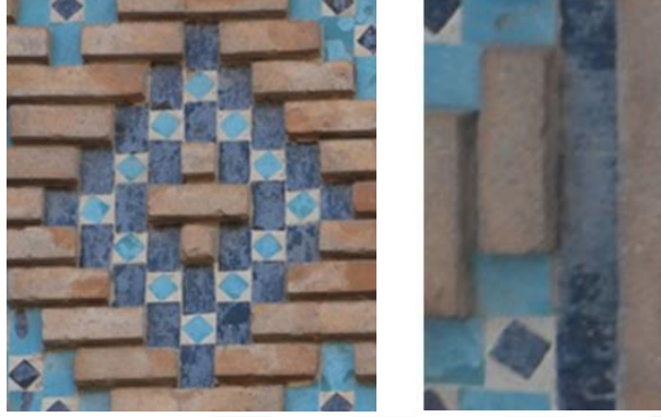
Resim 5. 195. Taç kapı, doğu kenar, “Ali” yazılı pano, renk bozulması.
