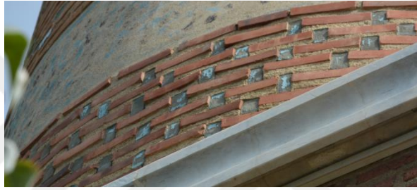
Resim 5. 134. Mescit, minare birinci şerefe altı birinci kuşak, kuzey cephe, tamamlama.
