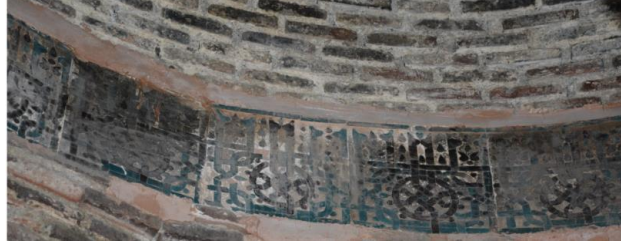
Resim 5. 81. T rbe, kubbe kasnađı, g ney-batı cephe, y zeysel kirlilik.
