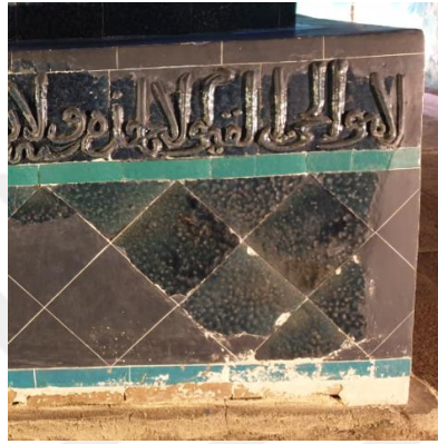
Resim 5. 407. Türbe, birinci sanduka, kaide kısmı, parça kaybı.
