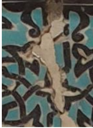
Resim 5. 485. Medrese, 8 no.lu pencere alınlık çinisi, parça kaybı.
