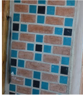
Resim 5. 567. Mescit, kapı açıklığı, karın kısmı, tamamlama.
