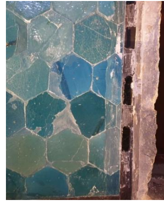
Resim 5. 382. Tübe, batı duvar, sol pano, parça kaybı.
