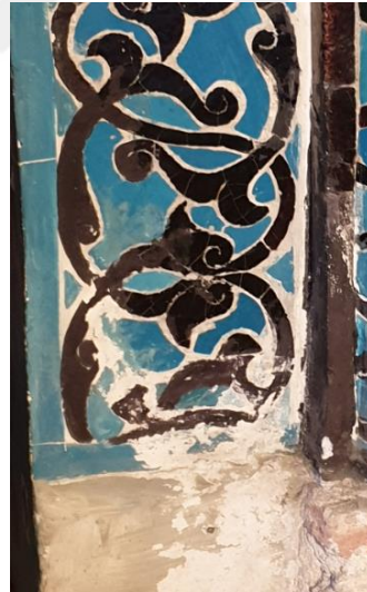
Resim 5. 355. Türbe, geçiş kapı, doğu taraf, yüzey boya ayrılmaları ve solmaları.
