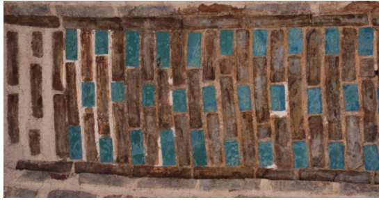
Resim 5. 150. Mescit, kuzey tonoz tepe kuşak, parça kaybı.
