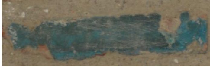
Resim 5. 53. Türbe eyvan, doğu duvar, sırlı tuğla, yüzeysel kirlilik.
