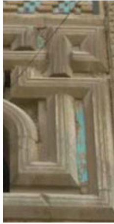
Resim 5. 190. Taç kapı, doğu kenar, düğümlü pano, birim malzeme kaybı (R.S.)
