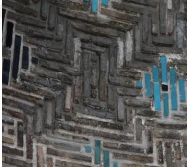
Resim 5. 500. Medrese, kubbe, batı cephe, aşınma-ufalanma.
