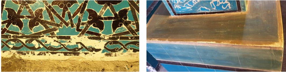
Resim 5. 415. Türbe, dördüncü sanduka, kuzey taraf, yüzey boya ayrılmaları ve kayıpları.
