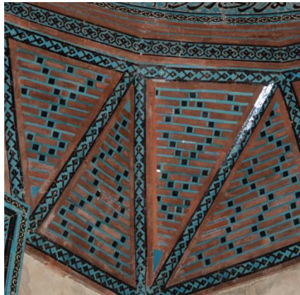
Resim 5. 675. Mescit, Türk üçgeni, güney cephe batı uç, nem
