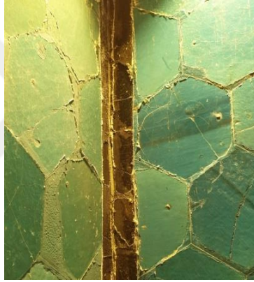
Resim 5. 386. Türbe, güney-batı duvar birleşimi, çiçeklenme-tuzlanma.
