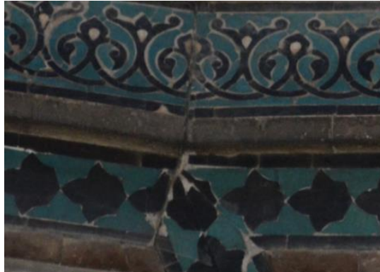
Resim 5. 506. Medrese, yirmi gen kuşak ve üçgen bingiler, güney-batı cephe, parça kaybı.
