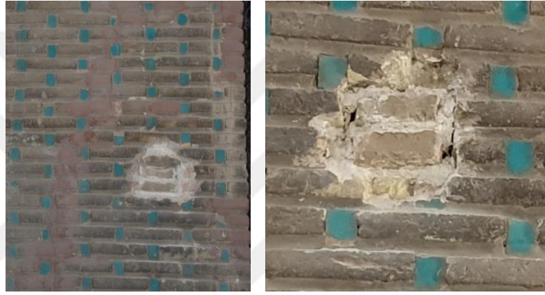
Resim 5. 517. Medrese, batı eyvan kemer karnı, güney cephe, tamamlama.
