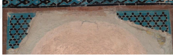
Resim 5. 669. Mescit, Türk üçgeni (doğu) niş köşelik çinileri, parça kaybı.
