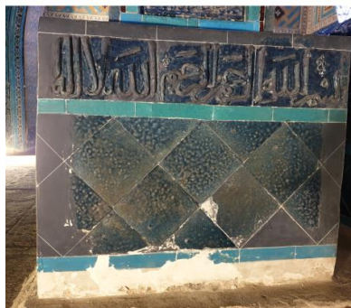
Resim 5. 402. Türbe, birinci sanduka baş taraf, birim malzeme kaybı. Resim 5. 403. Türbe, beşinci sanduka alt taraf, birim malzeme kaybı.
