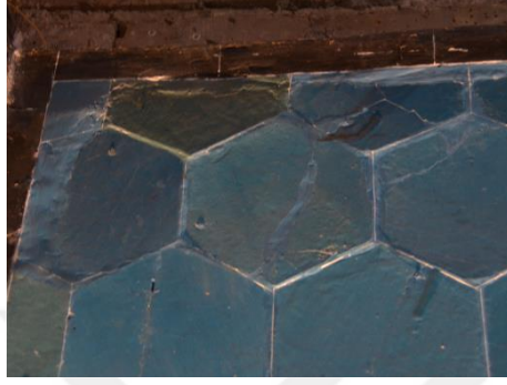
Resim 5. 380. Tübe, kuzey duvar, sol pano sol köşe, parça kaybı.
