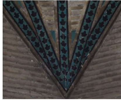
Resim 5. 504. Medrese, üçgen bingiler, kuzey-batı cephe, parça kaybı.
