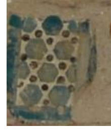
Resim 5. 33. Trbe eyvan, doęu duvar, 3 no. lu iniler, birim malzeme kaybı.
