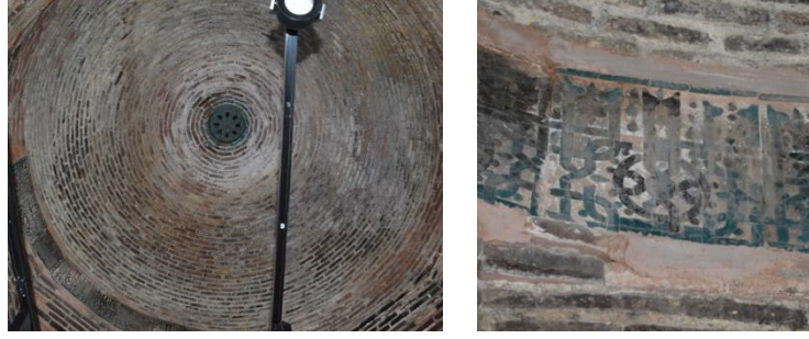
Resim 5. 83. Türbe, kubbe, malzeme kullanımı.
