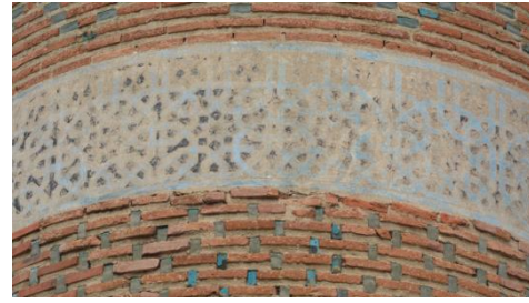
Resim 5.130. Mescit, minare birinci şerefe altı dördüncü kuşak, güney cephe, tamamlama.
