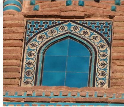
Resim 5. 655. Medrese, kuzey minare kaide ve pabuç kısmı, kuzey ve batı cephe, birim malzemedeki yenileme.
