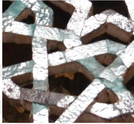
Resim 5. 287. Hankah, kuzey eyvan, pencere şebekesi, parça kaybı.
