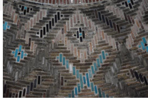
Resim 5. 500. Medrese, kubbe, batı cephe, aşınma-ufalanma.
