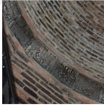
Resim 5. 79. Türbe, kubbe kasnağı, güney-batı cephe, is tabakası oluşumu.
