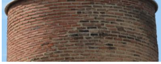
Resim 5. 128. Mescit, minare birinci şerefe, güney cephe, birim malzemedeki yenileme.
