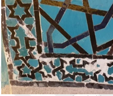
Resim 5. 365. Türbe, sivri kemer, kuzey taraf alt kısım, yüzey boya ayrılmaları. Resim 5. 366. Türbe, sivri kemer, doğu yüzey, güney taraf alt kısım, yüzey boya ayrılmaları.
