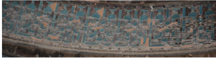
Resim 5. 489. Medrese, kubbe kasnağı, güney-doğu cephe, birim malzeme kaybı.
