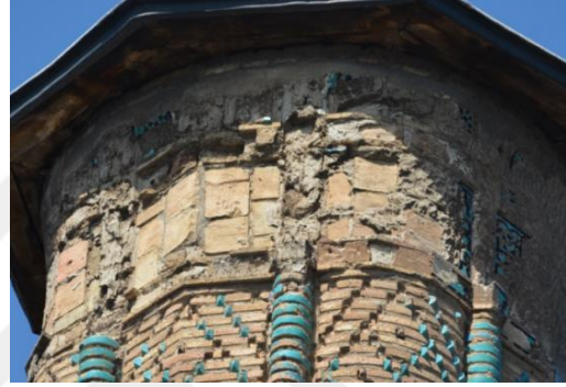
Resim 5. 457. Medrese, minare kuzey-batı cephe, birim malzeme kaybı.
