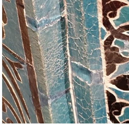
Resim 5. 363. Türbe, Sivri Kemer, Doğu yüz, Kuzey taraf, Tuz çıkışı detay.
