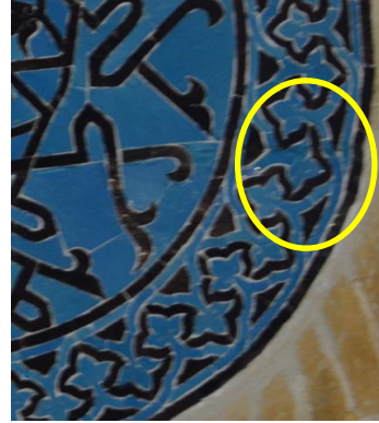
Resim 5. 398 Tübe, kubbe kasnak, pano birleşim kenarları, parça kaybı.
