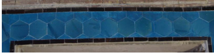
Resim 5. 371. Törbe, güney duvar, pencere üstü, birim malzeme kaybı.
