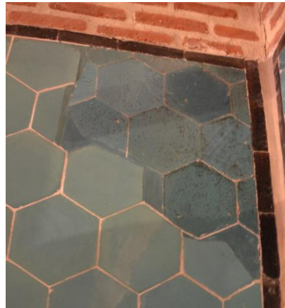
Resim 5. 270.Hankah, batı eyvan, sol duvar, sağ üst köşe, taşıyıcıda-birim malzemede yenileme ve özgün çini birleşimi.
