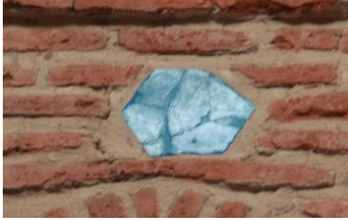
Resim 5. 297. Hankah, kubbe kasnak altı, batı eyvan üstü çini karo, parça kaybı.
