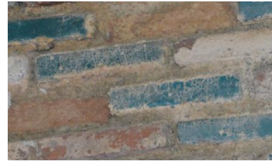
Resim 5. 64. Türbe, Türk üçgeni, güney-batı cephe, çatlak.
