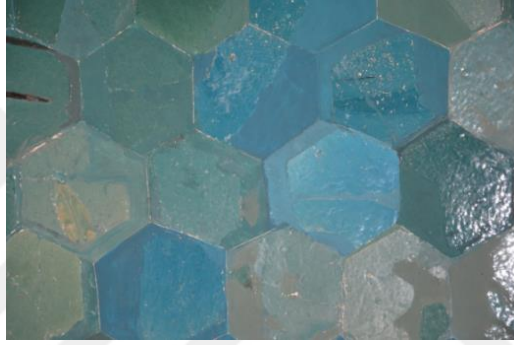
Resim 5. 271. Hankah, kuzey eyvan, ana eyvana bakan sol duvar pano, tamamlama .
