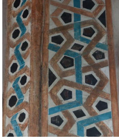
Resim 5. 566. Mescit, kapı açıklığı, kuzey taraf, yüzeysel kirlilik.
