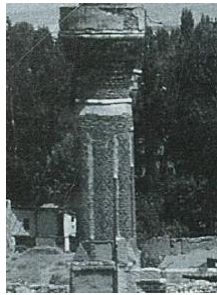
Resim 5. 682. Medrese, minare gövde kısmı, birim malzeme kaybı (Tuncer, 2008: 71).
