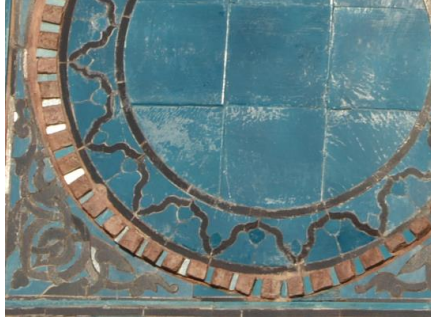
Resim 5. 653. Medrese, güney minare, batı cephe, yuvarlak kaide panosu, çatlak.
