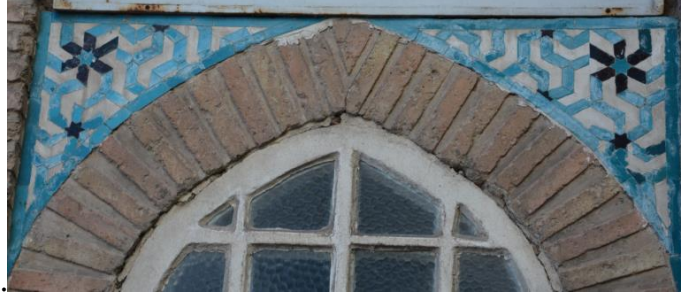
Resim 5. 578. Mescit, doğu cephe, pencere köşelik, tamamlama.
