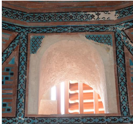
Resim 5. 665. Mescit, Türk üçgeni (doğu)niş köşelik çinileri, birim malzeme kaybı.
