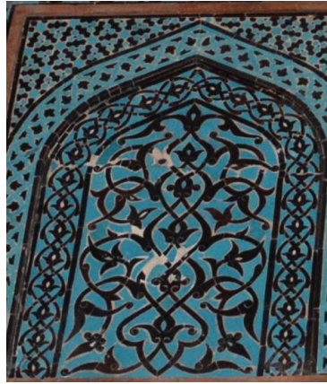
Resim 5. 670. Mescit, Türk üçgeni (batı) kör niş çinileri, parça kaybı.
