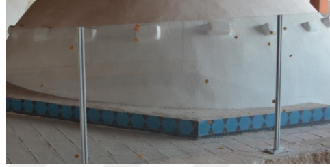
Resim 5. 660. Medrese, türbe batı duvar çinileri, birim malzeme kaybı.
