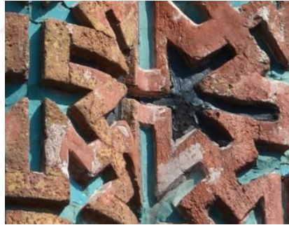
Resim 5. 205. Minare, dilimli gövde, batı taraf, birim malzeme kaybı.
