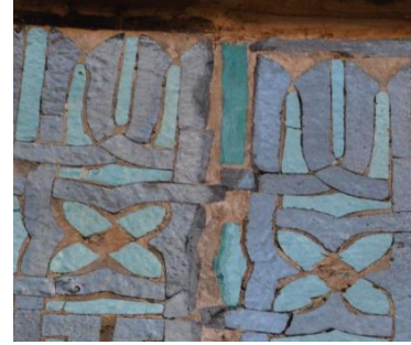
Resim 5. 297. Hankah, kubbe kasnak altı, batı eyvan üstü çini karo, parça kaybı.
