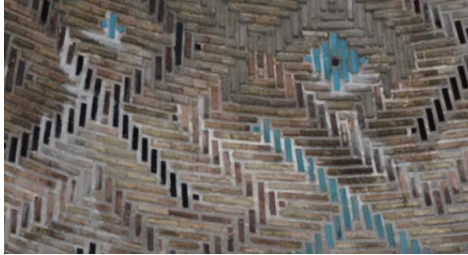
Resim 5. 514. Medrese, kubbe, güney cephe, birim malzemede yenileme.
