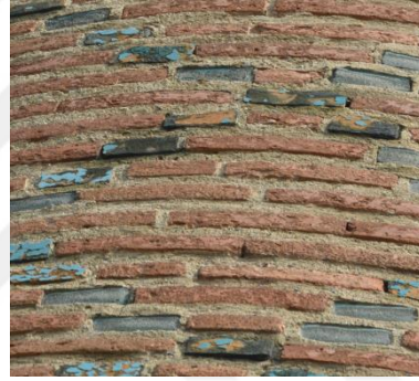
Resim 5. 176. Mescit, minare, sırlı tuğla yüzeyinde is tabakası oluşumu.
