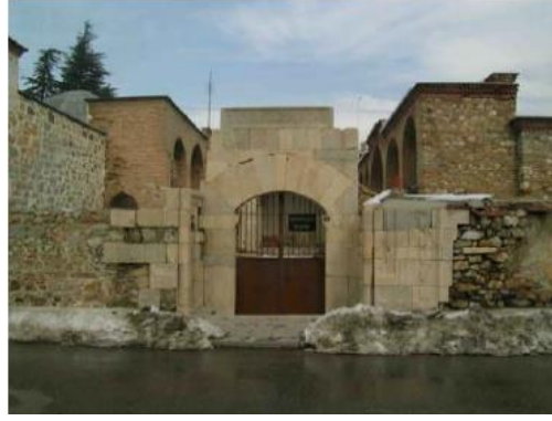
Resim 5. 9. Medrese, giriş (batı) cephe, taş kapı, 2007 yılındaki durumu (Yavaş, 2007: 63).
