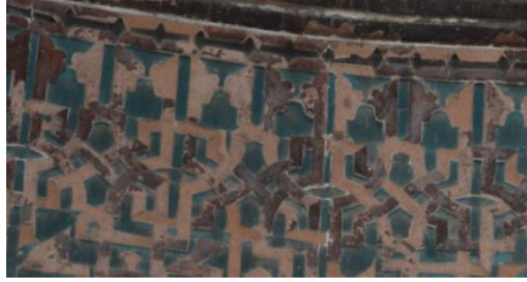
Resim 5. 507. Medrese, kubbe kasnağı, güney-doğu cephe, parça kaybı.
