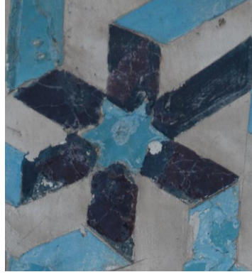
Resim 5. 576. Mescit, doğu cephe, pencere köşelik, sol (güney) taraf, parça kaybı.
