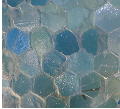
Resim 5. 389. Türbe, kuzey duvar, sol pano, tamamlama
