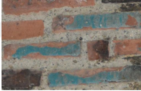
Resim 5. 74. Türbe, Türk üçgeni, güney cephe, parça kaybı.
