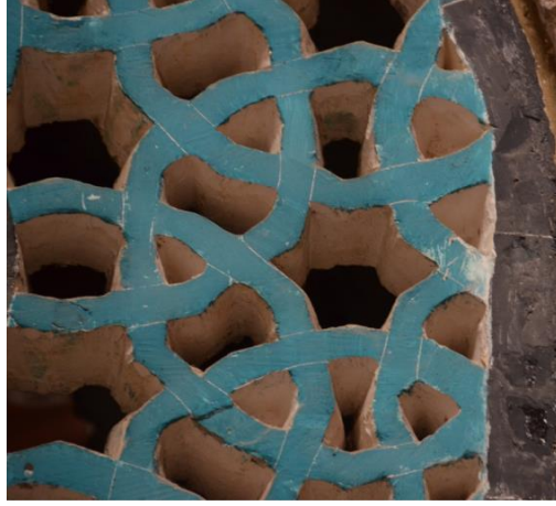
Resim 5. 292. Hankah, kuzey-batı cephe, pencere şebekesi, tamamlama, detay.
