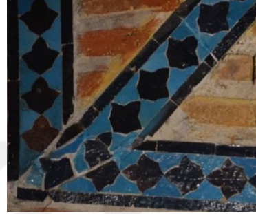
Resim 5. 396. Tübe, Türk üçgeni, güney cephe köşe birleşimi, parça kaybı.
