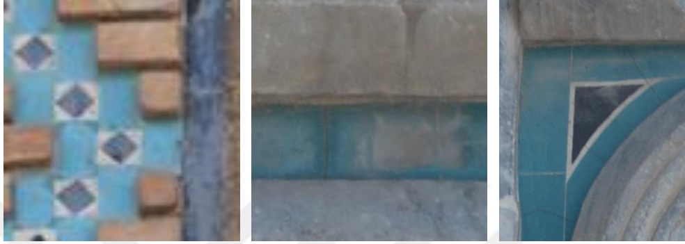
Resim 5. 201. Taç kapı, doğu kenar, “Ali” yazılı pano, renk bozulmaları.
