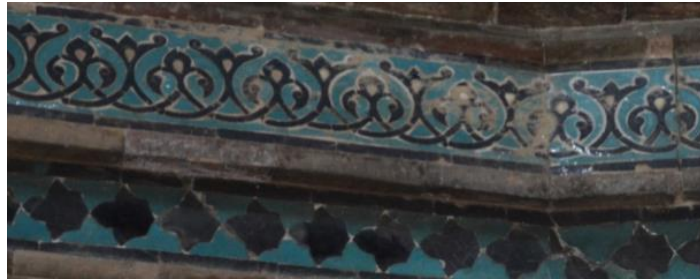
Resim 5. 512. Medrese, yirmi gen kuşak ve üçgen bingiler, güney-batı cephe, yüzey kirlilik.
