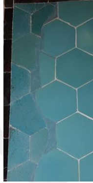
Resim 5. 268.Hankah, batı eyvan, sol duvar sol üst köşe, taşıyıcıda-birim malzemede yenileme.
