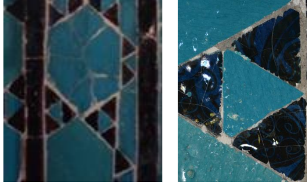
Resim 5. 215. Mihrap, kavsara, sağ üst köşe, çini hamur çatlak-kırık.
