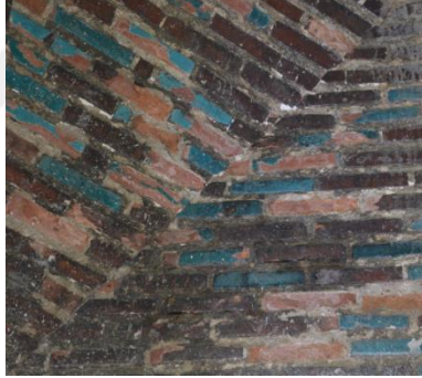
Resim 5. 67. T rbe, T rk   genleri, g ney-batı cephe, par a kaybı.
