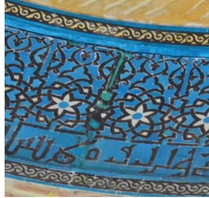
Resim 5. 398 Tübe, kubbe kasnak, pano birleşim kenarları, parça kaybı.
