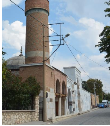
Resim 5. 11. Medrese, giriş (batı) cephe, günümüzdeki durumu
