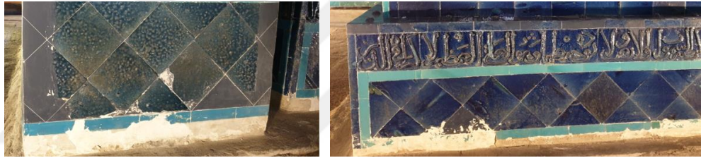
Resim 5. 413. Türbe, bir ve ikinci sandukalar, yüzey boya ayrılmaları ve kayıpları.
