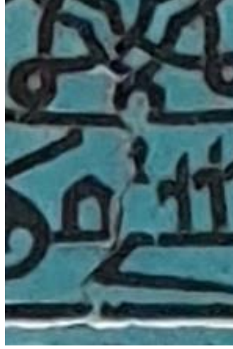
Resim 5. 478. 7 no.lu pencere alınlık çinisi, çatlak.
