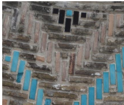
Resim 5. 516. Medrese, kubbe, güney cephe, birim malzemede yenileme.
