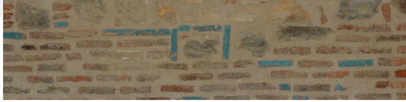
Resim 5. 57. Türbe eyvan, doğu duvar, sırlı tuğla, tamamlama.
