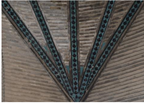
Resim 5. 504. Medrese, üçgen bingiler, kuzey-batı cephe, parça kaybı.
