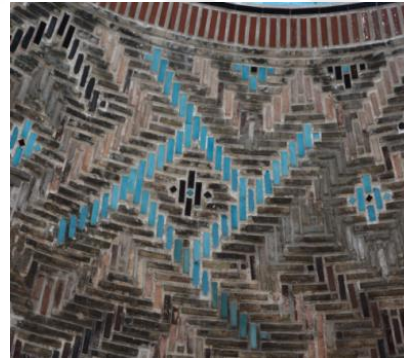
Resim 5. 493. Medrese, kubbe, doğu cephe, turkuaz sırlı tuğlalarda birim malzeme kaybı.
