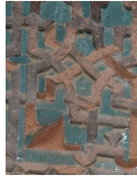
Resim 5. 490. Medrese, kubbe kasnağı, güney cephe, birim malzeme kaybı.
