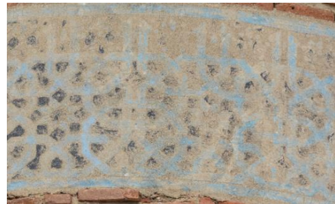
Resim 5. 135. Mescit, minare birinci şerefe altı birinci kuşak, güney cephe, yüzey boya ayrılmaları ve kayıpları.
