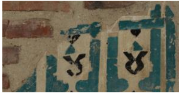
Resim 5. 32. Tübe eyvan, doğu duvar, 1 no. lu çini, birim malzeme kaybı.
