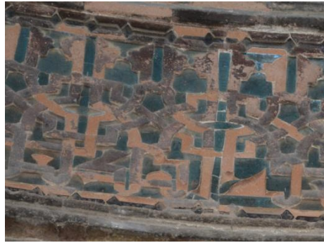
Resim 5. 490. Medrese, kubbe kasnağı, güney cephe, birim malzeme kaybı.
