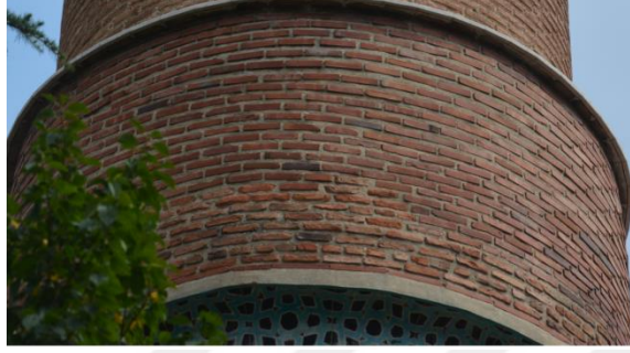
Resim 5. 129. Mescit, minare birinci şerefe, güney-doğu ve doğu cephe, tamamlama.
