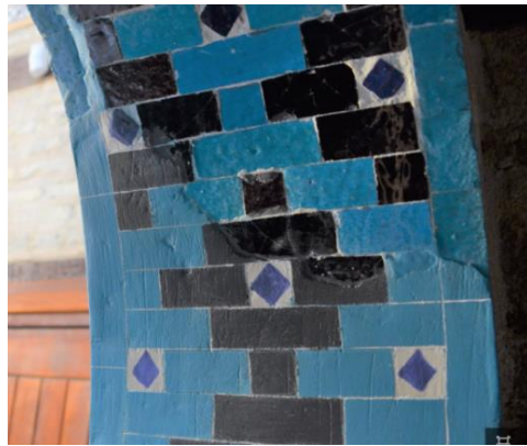
Resim 5. 354. Türbe, geçiş kapı kemerinin doğu tarafı, tamamlama.
