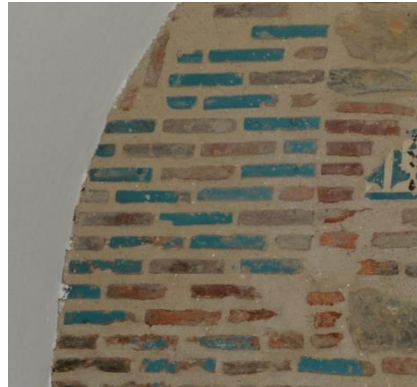
Resim 5. 58. Türbe eyvan, doğu duvar, sol-üst köşe sırlı tuğla, tamamlama.
