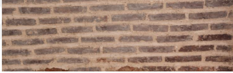
Resim 5. 160. Mescit, kuzey tonoz, yüzey badana-sıva uygulaması.
