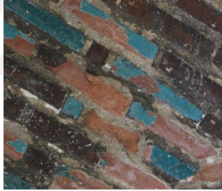
Resim 5. 63. Medrese, Türk üçgenleri, güney-batı cephe, aşınma-ufalanma.
