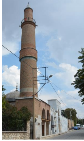
Resim 5. 5. Medrese, kuzey-batı cephe görünüşü.
