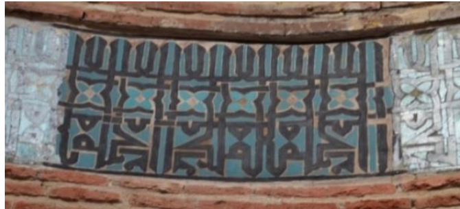
Resim 5. 294. Hankah, kubbe kasnak, batı eyvan üstü pano, birim malzeme kaybı.
