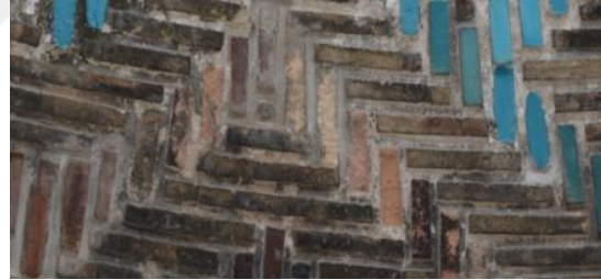
Resim 5. 514. Medrese, kubbe, güney cephe, birim malzemede yenileme.
