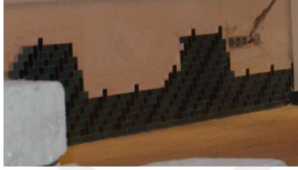
Resim 5. 660. Medrese, türbe batı duvar çinileri, birim malzeme kaybı.
