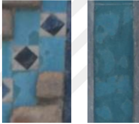
Resim 5. 192. Taç kapı, doğu kenar, “Ali” yazılı pano, parça kaybı.
