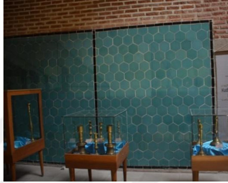
Resim 5. 268.Hankah, batı eyvan, sol duvar sol üst köşe, taşıyıcıda-birim malzemede yenileme.
