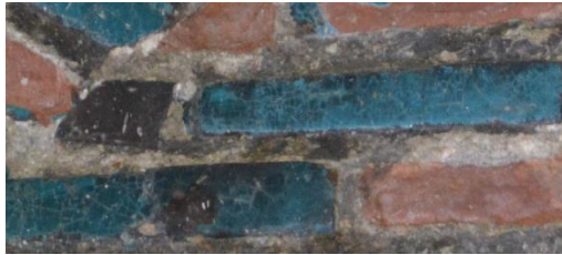
Resim 5. 64. Türbe, Türk üçgeni, güney-batı cephe, çatlak.
