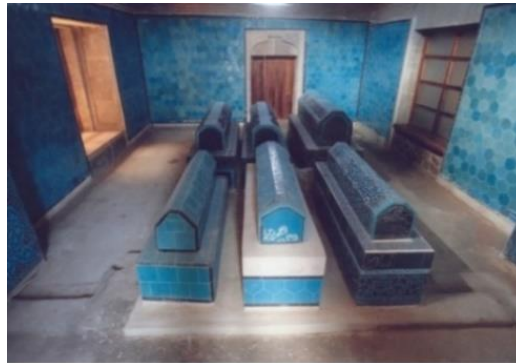
Resim 5. 317. Türbe, mevcut hali.
