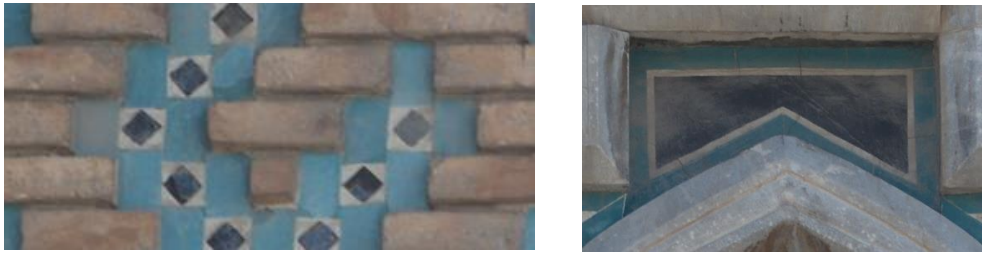
Resim 5. 197. Taç kapı, batı kenar, yazılı pano, yüzeysel kirlilik.
