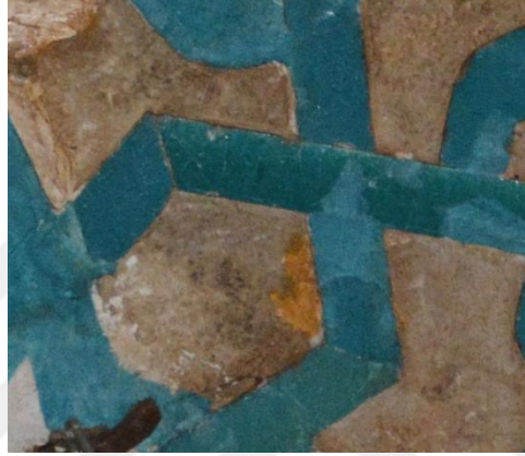
Resim 5. 588. Mescit, kubbe göbeği, parça kaybı.
