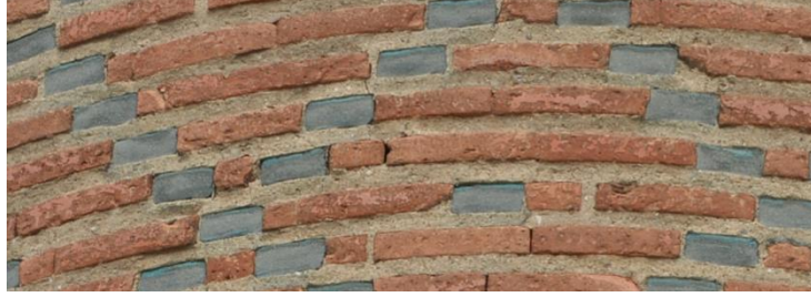
Resim 5. 178. Mescit, minare, üçüncü kuşak, batı cephe.
