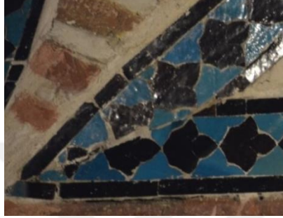
Resim 5. 396. Tübe, Türk üçgeni, güney cephe köşe birleşimi, parça kaybı.
