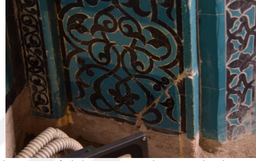
Resim 5. 365. Türbe, sivri kemer, kuzey taraf alt kısım, yüzey boya ayrılmaları. Resim 5. 366. Türbe, sivri kemer, doğu yüzey, güney taraf alt kısım, yüzey boya ayrılmaları.
