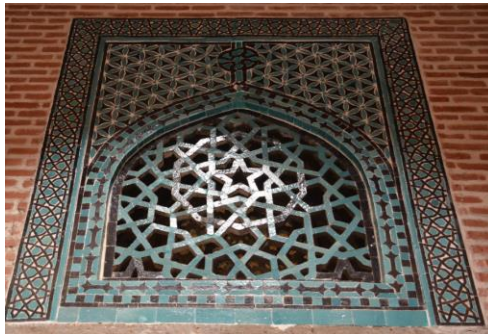
Resim 5. 280. Hankah, kuzey eyvan, pencere şebekesi, birim malzeme kaybı.
