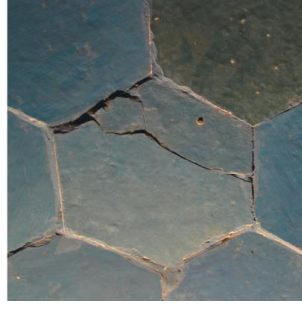
Resim 5. 375. Türbe, kuzey duvar, sol pano, kırık.
