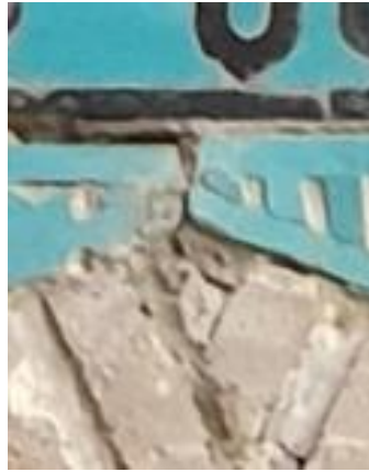
Resim 5. 482. Medrese, 6 no.lu pencere alınlık çini üst kısım, parça kaybı.
