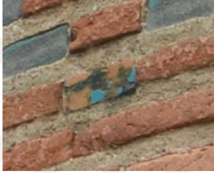
Resim 5. 176. Mescit, minare, sırlı tuğla yüzeyinde is tabakası oluşumu.
