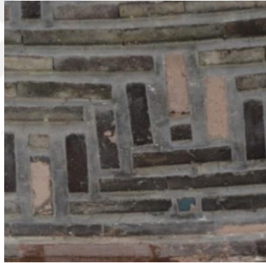
Resim 5. 508. Medrese, kubbe, batı cephe, parça kaybı.
