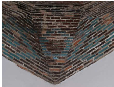
Resim 5. 71. T rbe, T rk   genleri, kuzey-batı cephe, par a kaybı.
