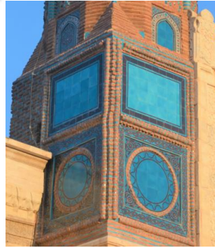
Resim 5. 655. Medrese, kuzey minare kaide ve pabuç kısmı, kuzey ve batı cephe, birim malzemedeki yenileme.
