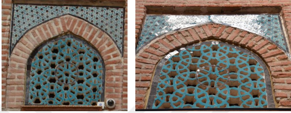
Resim 5. 284. Hankah, kuzey-doğu, pencere şebekesi, birim malzeme kaybı.
