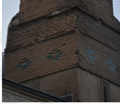
Resim 5. 438. Medrese, minare tuğla kaide kısmı.
