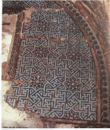
Resim 5. 640. Medrese, güney eyvan, arka duvar çinileri (Tuncer, 2008: 90).
