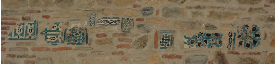
Resim 5. 56. Türbe eyvan, doğu duvar, çiniler, tamamlama.
