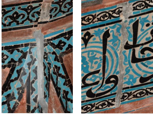
Resim 5. 673. Mescit, güney cephe, Türk üçgenleri, tamamlama.
