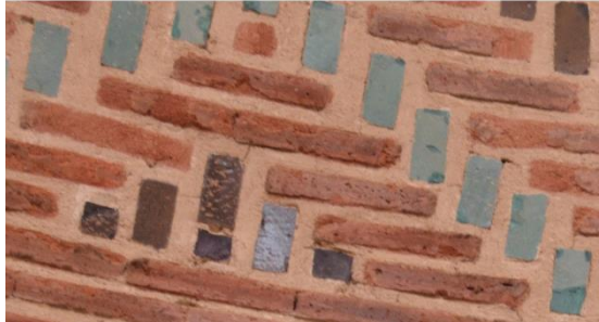
Resim 5. 299. Hankah, kubbe, sırlı tuğla, parça kaybı.
