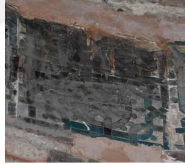
Resim 5. 79. Türbe, kubbe kasnağı, güney-batı cephe, is tabakası oluşumu.
