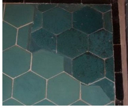
Resim 5. 251. Halka, batı eyvan, sol pano, sağ üst köşe, özgün çiniler. Resim 5. 252. Halka, batı eyvan, sağ pano, sonradan üretim çiniler, birim malzeme kaybı.
