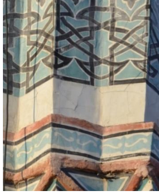
Resim 5. 211. Minare, zikzak kuşak, doğu taraf, yüzey boya ayrılmaları ve solmaları.
