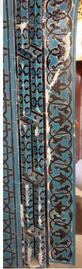
Resim 5. 355. Türbe, geçiş kapı, doğu taraf, yüzey boya ayrılmaları ve solmaları.
