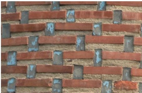
Resim 5. 135. Mescit, minare birinci şerefe altı birinci kuşak, güney cephe, yüzey boya ayrılmaları ve kayıpları.
