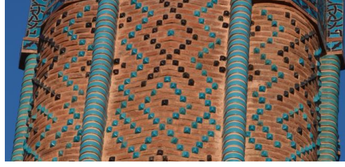
Resim 5. 657. Medrese, kuzey minare gövde kısmı, batı cephe, birim malzemede yenileme.
