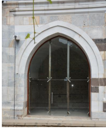
Resim 5. 12. Medrese, türbe eyvan, batı (giriş) cephe, dış görünüş.
