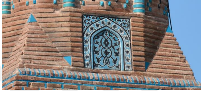
Resim 5. 625. Medrese, minare, kaide ve pabuç kısmı, doğu cephe.
