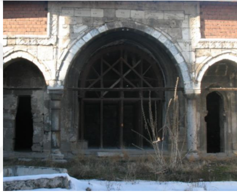
Resim 5. 617. Medrese, güney eyvan, çinileri koruma iskelesi, 2006(V.B.M.). Resim 5. 618. Medrese, güney eyvan çinileri koruma iskele detay, 2006 (V.B.M.).
