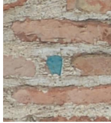
Resim 5. 146. Mescit, kuzey sivri kemer, parça kaybı.
