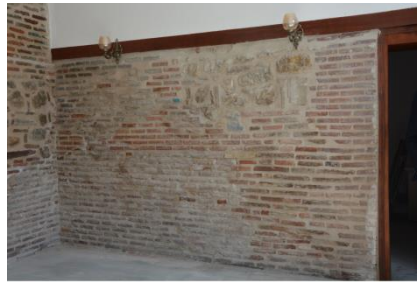
Resim 5. 14. Medrese, Türbe eyvan, güney duvar ve kapı açıklığı.
