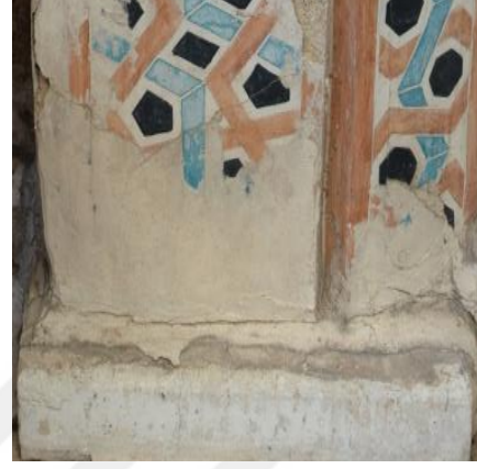
Resim 5. 571. Mescit, kapı açıklığı, sol (güney) taraf, alt kısım, parça kaybı.
