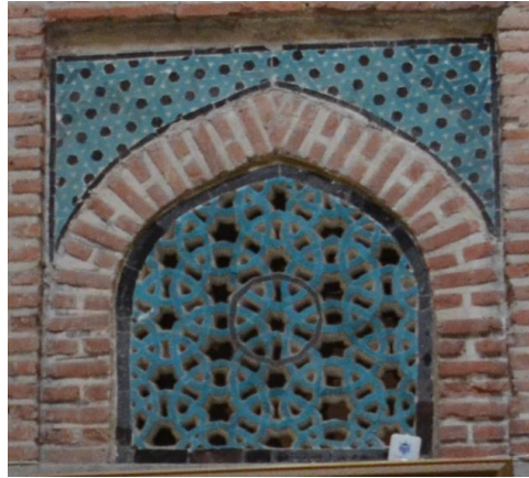
Resim 5. 286. Hankah, güney-batı, pencere şebekesi, birim malzeme kaybı.
