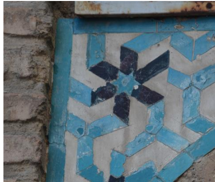
Resim 5. 573. Mescit, doğu cephe, pencere köşelik, sol (güney) taraf, birim malzeme kaybı.
