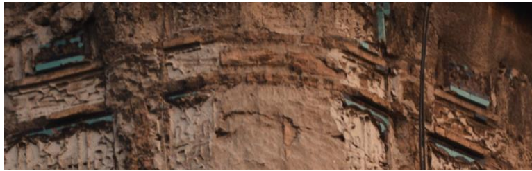
Resim 5. 465. Medrese, minare şerefe altı pano, batı cephe, parça kaybı.
