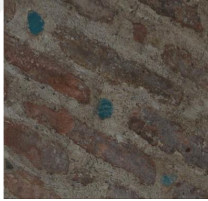
Resim 5. 146. Mescit, kuzey sivri kemer, parça kaybı.
