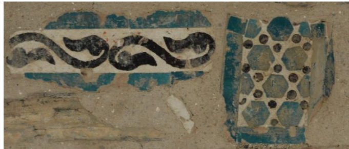
Resim 5. 52. Türbe eyvan, doğu duvar, 5 ve 16 no. lu çiniler, yüzeysel kirlilik.
