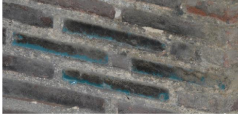
Resim 5. 77. Türbe, Türk üçgenleri, güney-batı cephe, yüzey kirlilik/ is tabakası oluşumu.
