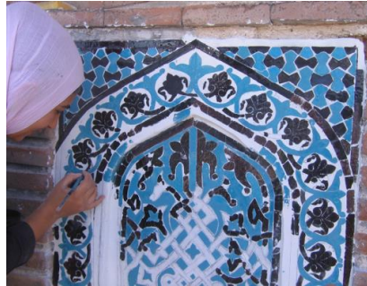
Resim 5. 619. Medrese, minare çinilerinin onarımı, 2007(V.B.M.). Resim 5. 620. Medrese, güney eyvan çinilerinin onarımı, 2007(V.B.M.).
