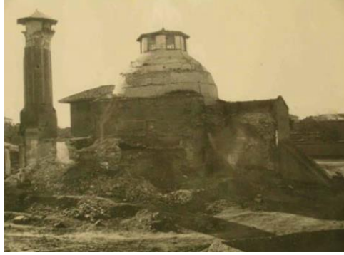
Resim 5. 437. Mescidin 20. yüzyıl başındaki yıkık durumu (V.B.M.).
