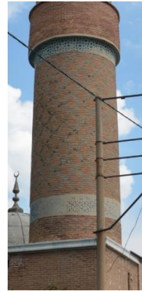
Resim 5. 114. Mescit, minare bir, iki ve dördüncü kuşak, kuzey, kuzey-batı cephe, Taşıyıcı sorunu.
