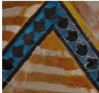
Resim 5. 394. Türbe, Türk üçgenleri, batı pencere üstü kısım, birim malzeme kaybı detay.
