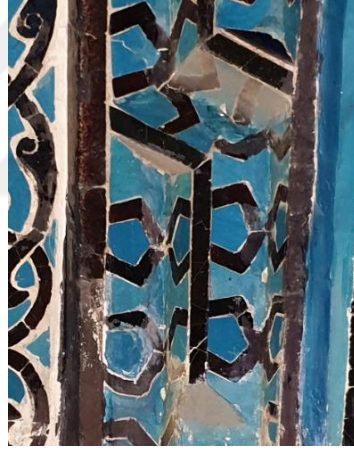
Resim 5. 349. Türbe, geçiş kapı, batı alt taraf, yüzey kirliliği.
