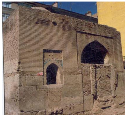
Resim 5. 548. Mescit giriş cephesi, 1990 yılındaki durumu (Baş, 2008: 90).
