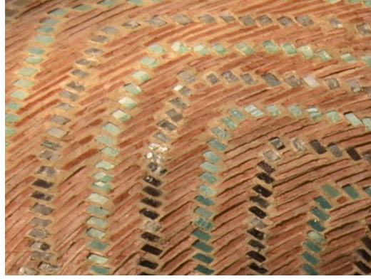
Resim 5. 295. Hankah, kubbe kasnak, batı eyvan sol yan üstü, birim malzeme kaybı.
