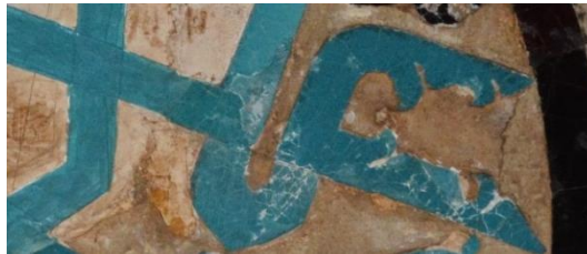
Resim 5. 589. Mescit, kubbe göbeği, sır çatlağı.
