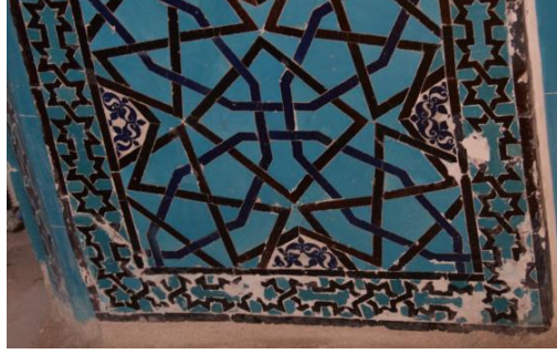
Resim 5. 359. Tübe, sivri kemer, kuzey taraf, parça kaybı.
