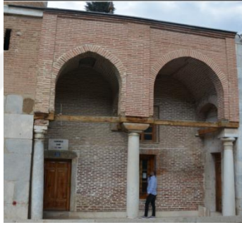
Resim 5. 141. Mescit, kuzey sivri kemer, taşıyıcı sorunu.
