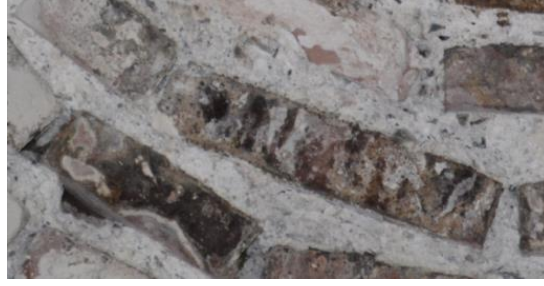
Resim 5. 88. Türbe, kubbe- detay, beyaz badana altında kalan sır yüzey dökülmeleri.
