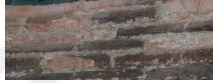
Resim 5. 61. Medrese, Türk üçgenleri, doğu cephe, aşınma-ufalanma.
