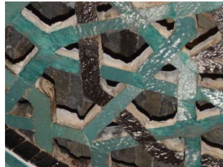
Resim 5. 280. Hankah, kuzey eyvan, pencere şebekesi, birim malzeme kaybı.
