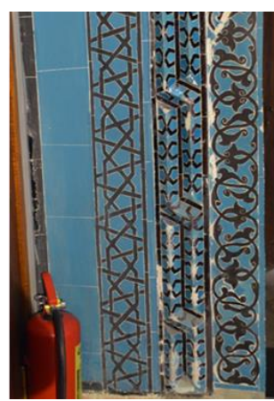
Resim 5. 340. Türbe, geçiş kapı, doğu (sağ) taraf kuşaklar üst kısım, birim malzeme kaybı.
