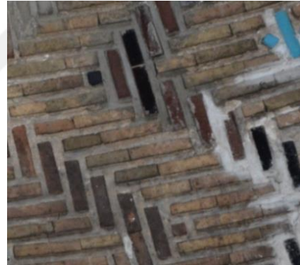
Resim 5. 508. Medrese, kubbe, batı cephe, parça kaybı.
