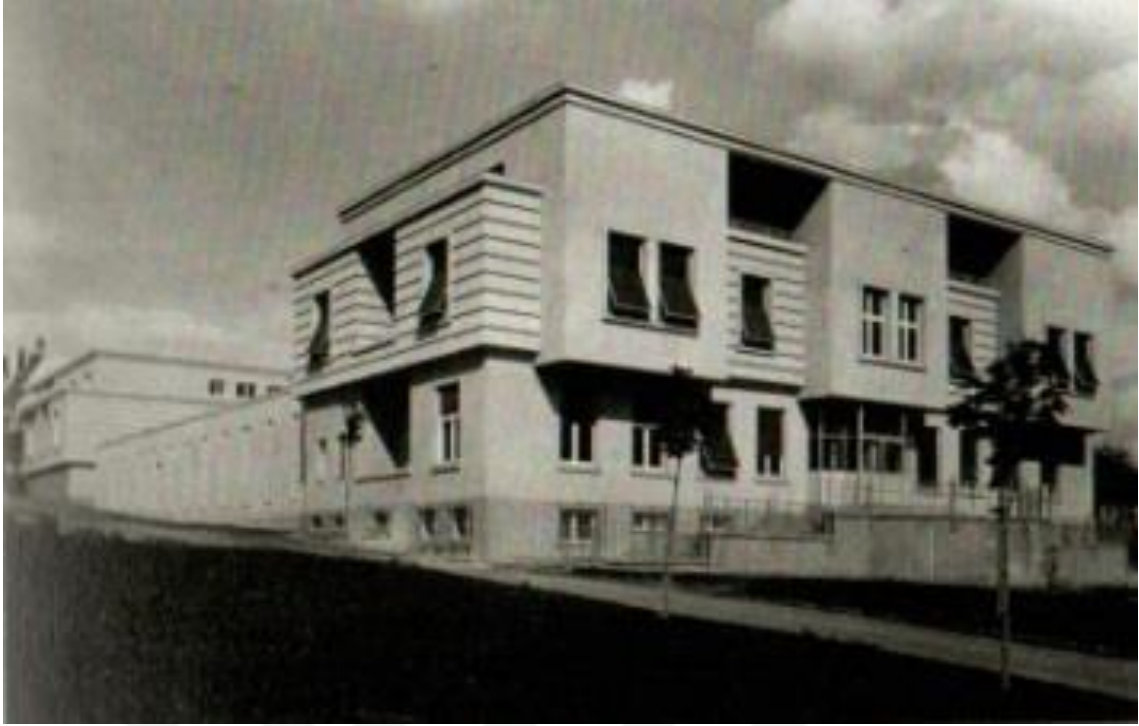
Şekil 7. 74: Sayıştay Binası, Arka Cephe, 1928 212
