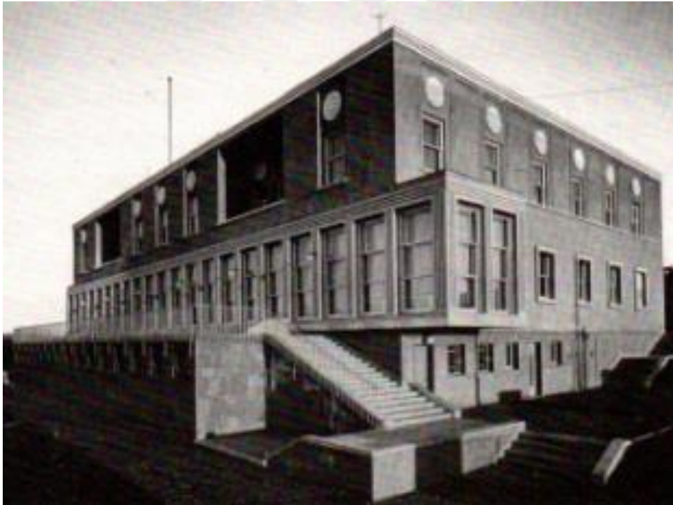
Şekil 7. 105: Irak Büyükelçiliği Binası, Arka Cephe, 1936 231
