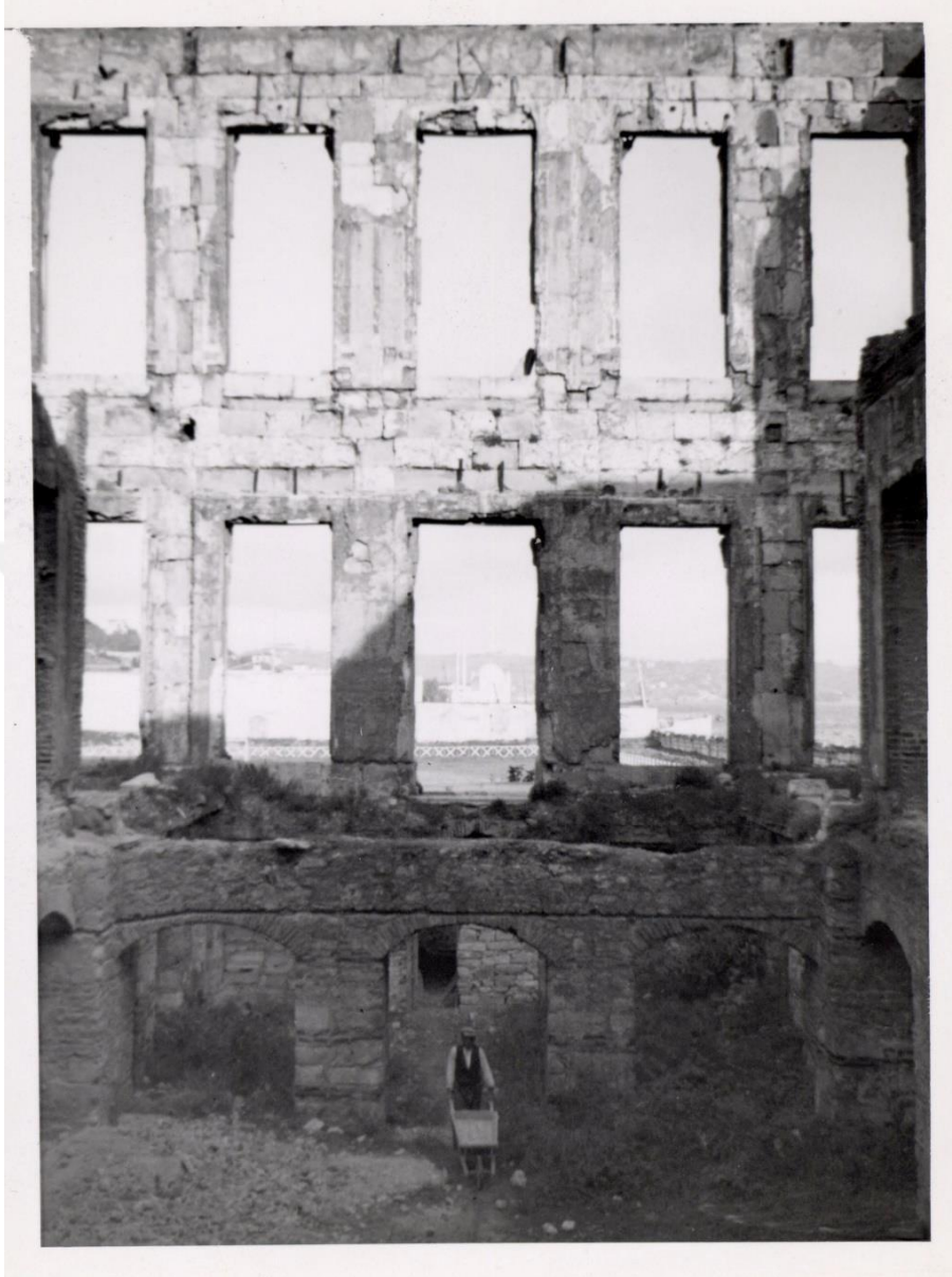
Ek 10: ıraęan Sarayı'nın duvar enkazı.
