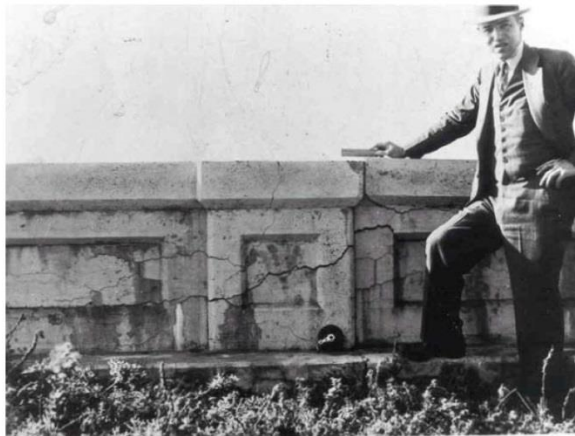
Şekil 2.5 Thomas Stanton ve bir parapet duvarda ASR kaynaklı hasar (Thomas et al., 2013).
