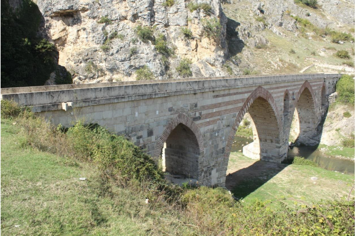
Şekil 12: Tekkekıran Mahallesi, Kurt Köprü
