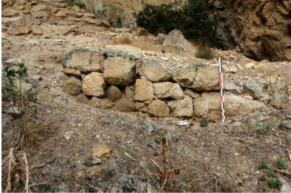
Şekil 8: Kaplancık Mahallesi, Kanyon Bedesten Mevkii, istinat duvarı
