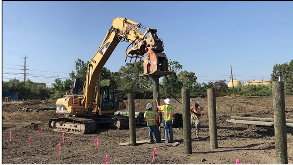
Şekil 2.3. Ahşap çakma kazık uygulaması
