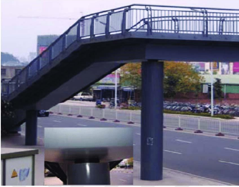
Şekil 1.1. Beton doldurulmuş çelik tüp kolon yapı elemanı
