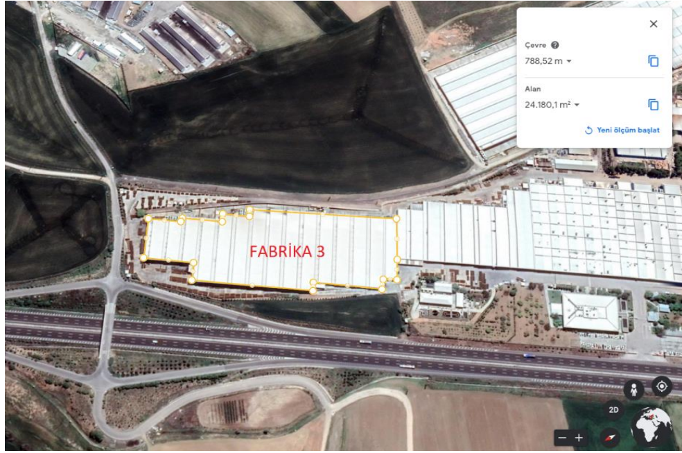
Görsel 3.10. Ortadoğu Rulman Sanayi fabrika-3 çatı ölçüsü
