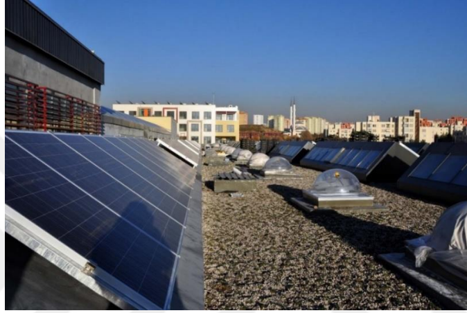
Şekil 4.9. Atölye bölümü üzerinde kahverengi çatı uygulaması (URL-39).
