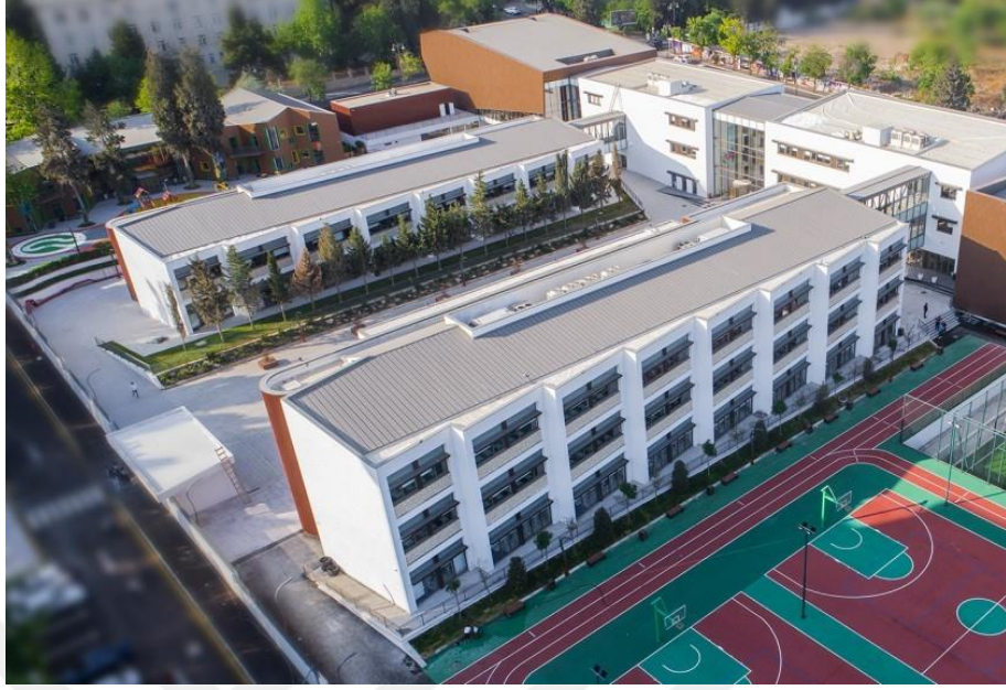
Şekil 4.63. Bakü MTK Okulları’nda dezaks olarak yerleştirilen sınıf cephesi (Bakü MTK Okulları Fotoğraf Arşivi).
