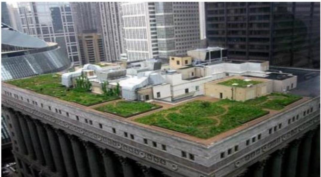
Şekil 3.3: Chicago Belediye Sarayı'nın Yeşil Çatısı [69]
