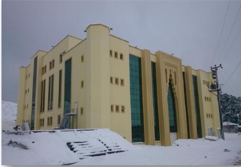
Şekil 4.3: Yalova Üniversitesi Mühendislik Fakültesi Binası
