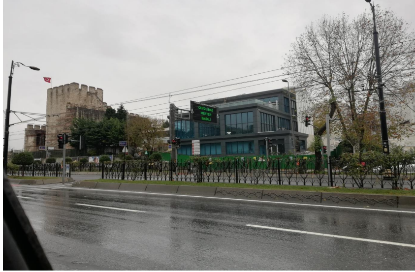
Şekil 1.1 Fatih Belediyesi Topkapı Sosyal Tesisleri
