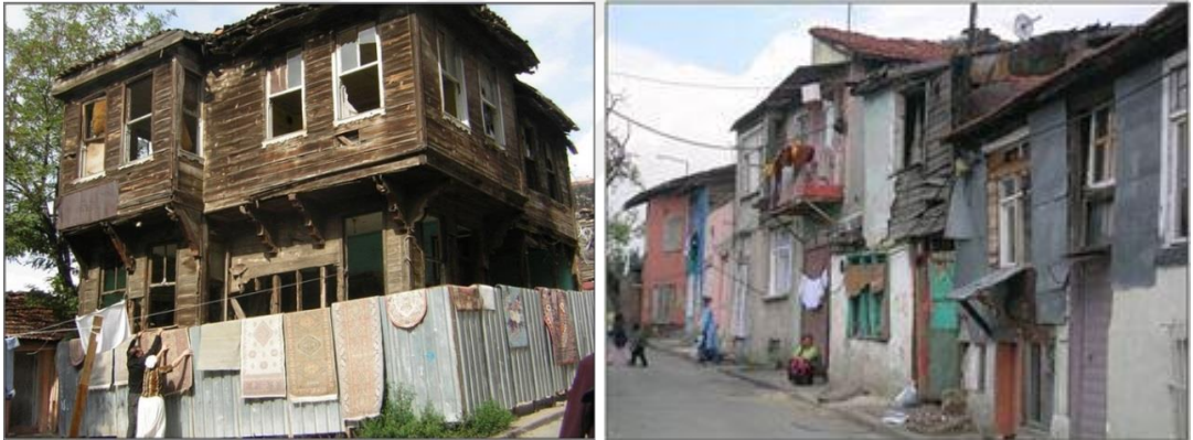
Kentsel dönüşüm öncesi
