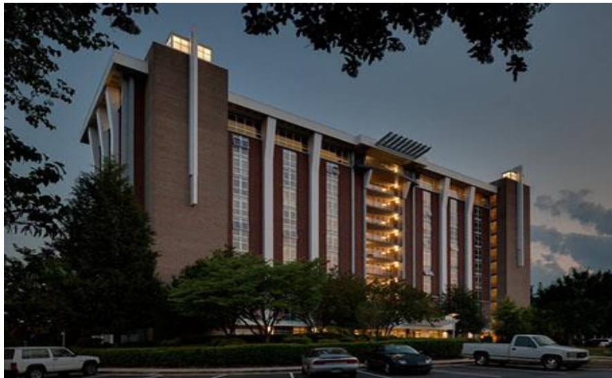
Şekil 4.2. “Charlottesville Terrace Renovations” (Yeşil Bina Sertifikası, 2021)
