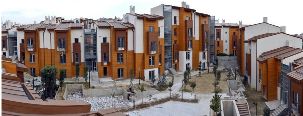
Kentsel dönüşüm sonrası
