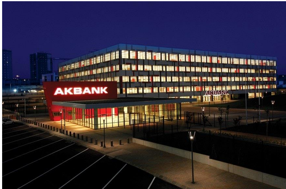
Şekil 4.12. Akbank Veri Merkezi (OBS İleri Yapı ve Deprem, 2021)
