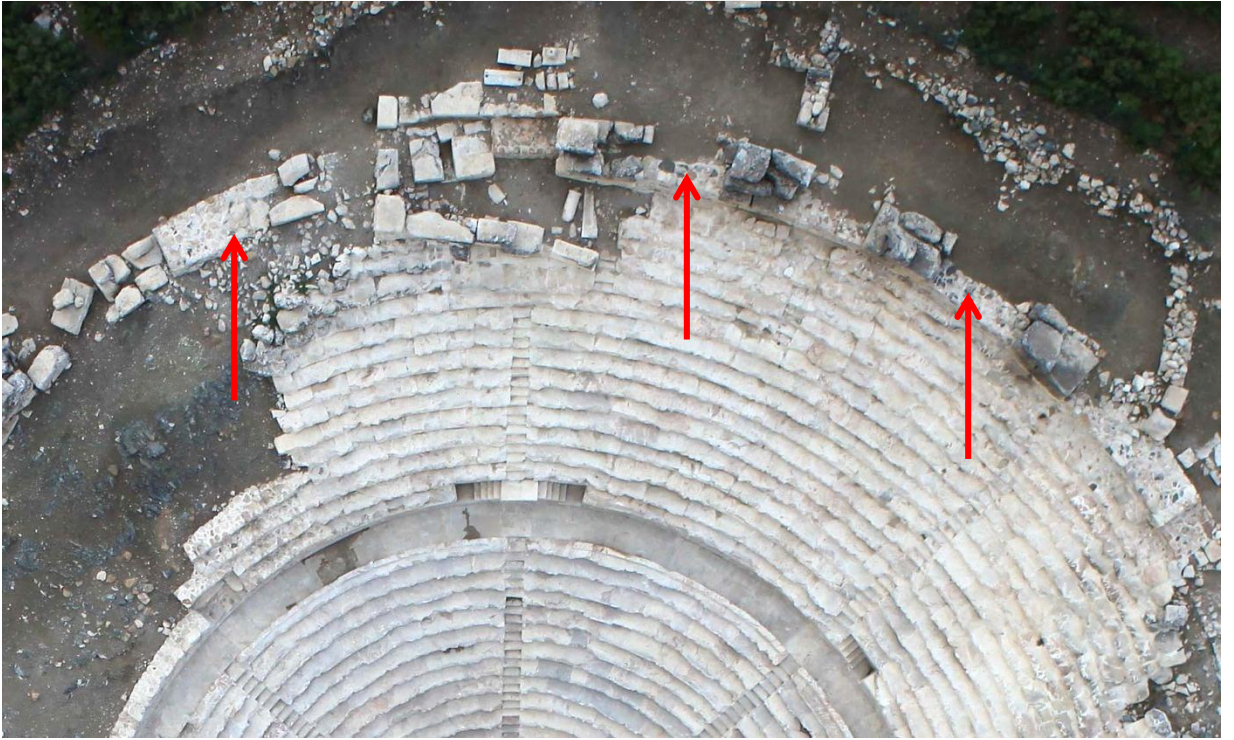
Res. 2 - Çevre Duvarı Pencere Payeleri Arasındaki Moloz Taş Duvarlar
