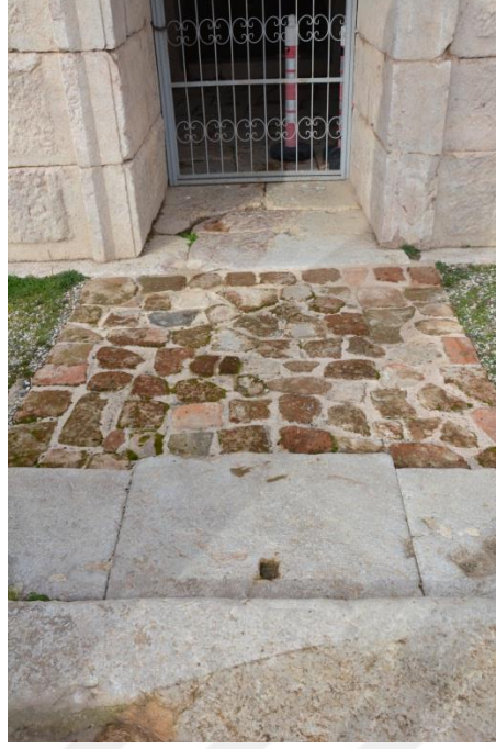
Res. 1 – Kuzey Giriş Yolu
