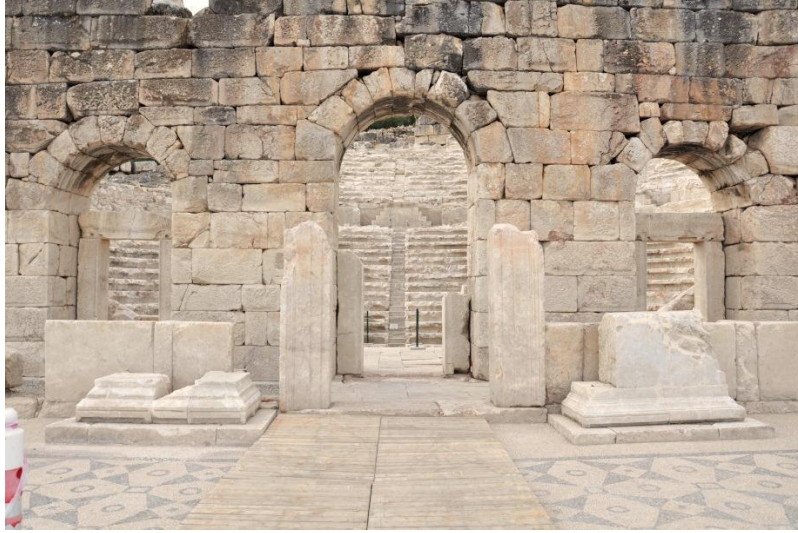
Res. 1 – Stoa Arka Duvarı Merkez Kapı
