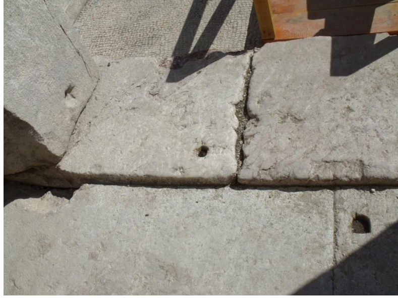
Res. 1 - Stoa Arka Duvarı Merkez Kapı Eşik Detay
