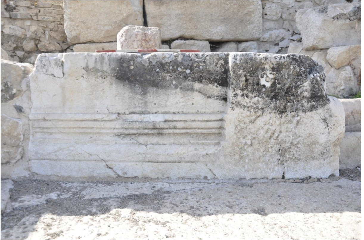
Res. 2 - Merkez Cavea Üstü Mimari Düzenlemesi Yerinden Kaymış Blok
