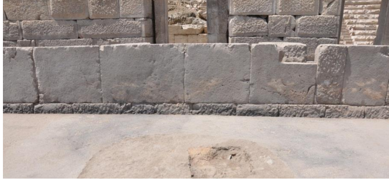
Res. 1 – Stoa Arka Duvarı
