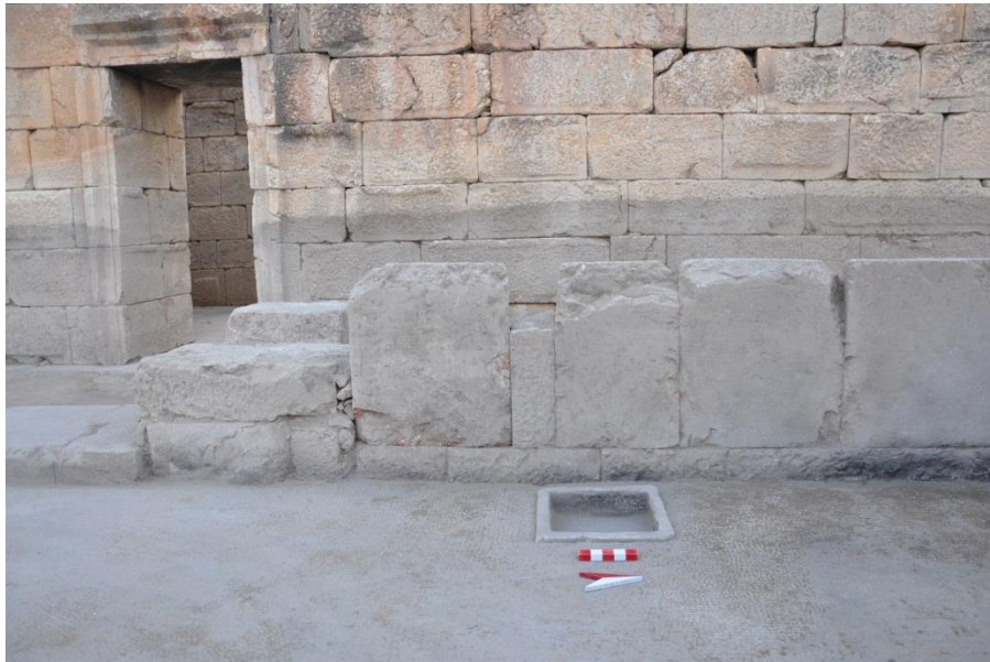
Res. 4 – Stoa Arka Duvarı Güney Taraf ve Önünde Bulunan Su Gideri
