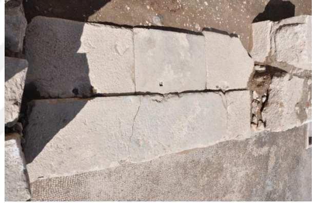
Res. 3 - Stoa Arka Duvarı Güney Kapı Eşik Detay
