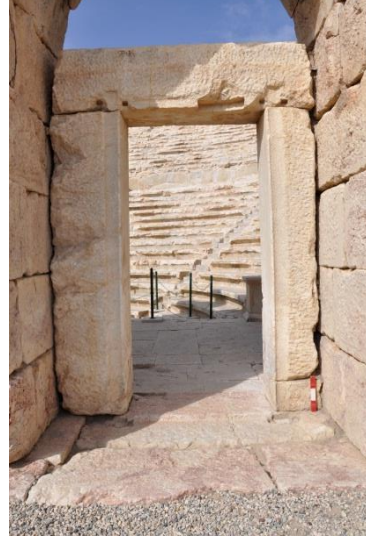
Res. 2 – IV. Kapı Dış
