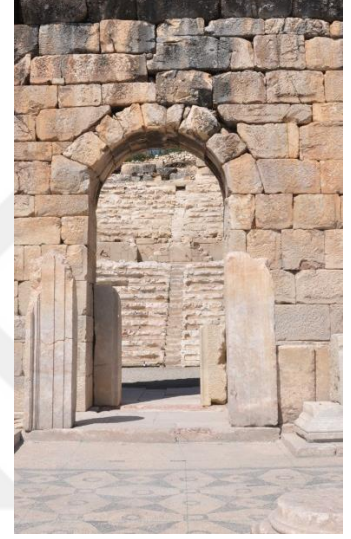
Res. 3 – Stoa Arka Duvarı Merkez Kapı
