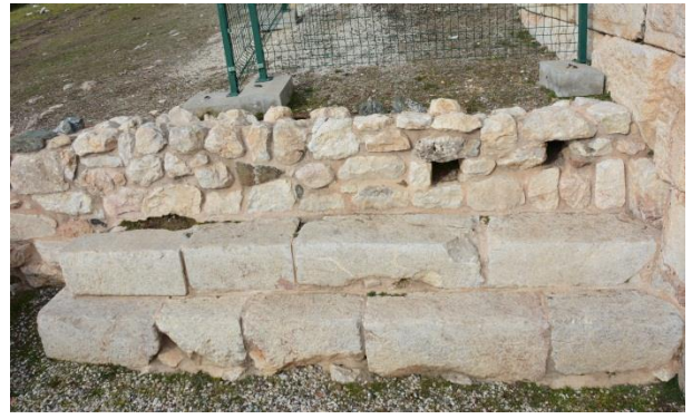
Res. 2 – Güney Çevre Duvarı Basamaklar
