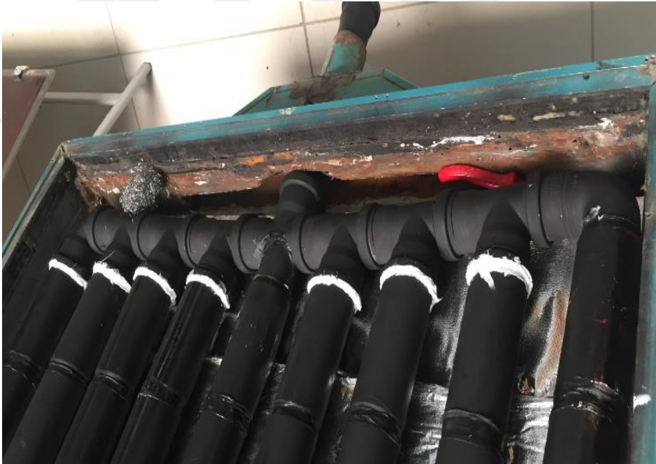
Şekil 5.5. Kola kutusu hatlarında sızdırmazlık sağlanırken
