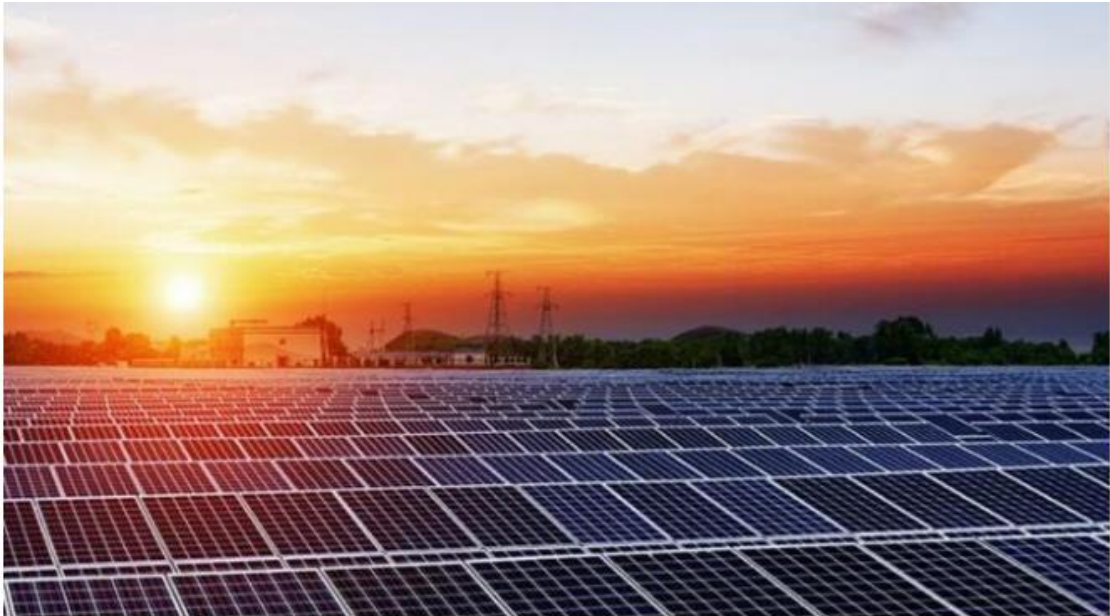
Şekil 3.3. Güneş enerjisinden faydalanmak için yapılmış güneş enerjisi uygulaması (URL2,2021)
