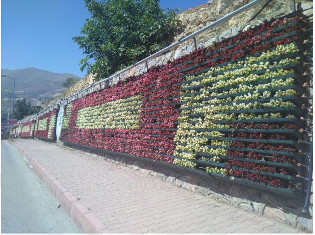
Şekil 5.11. Gedik Mahallesi Çırmıktı yolu Dikey bahçe uygulaması
