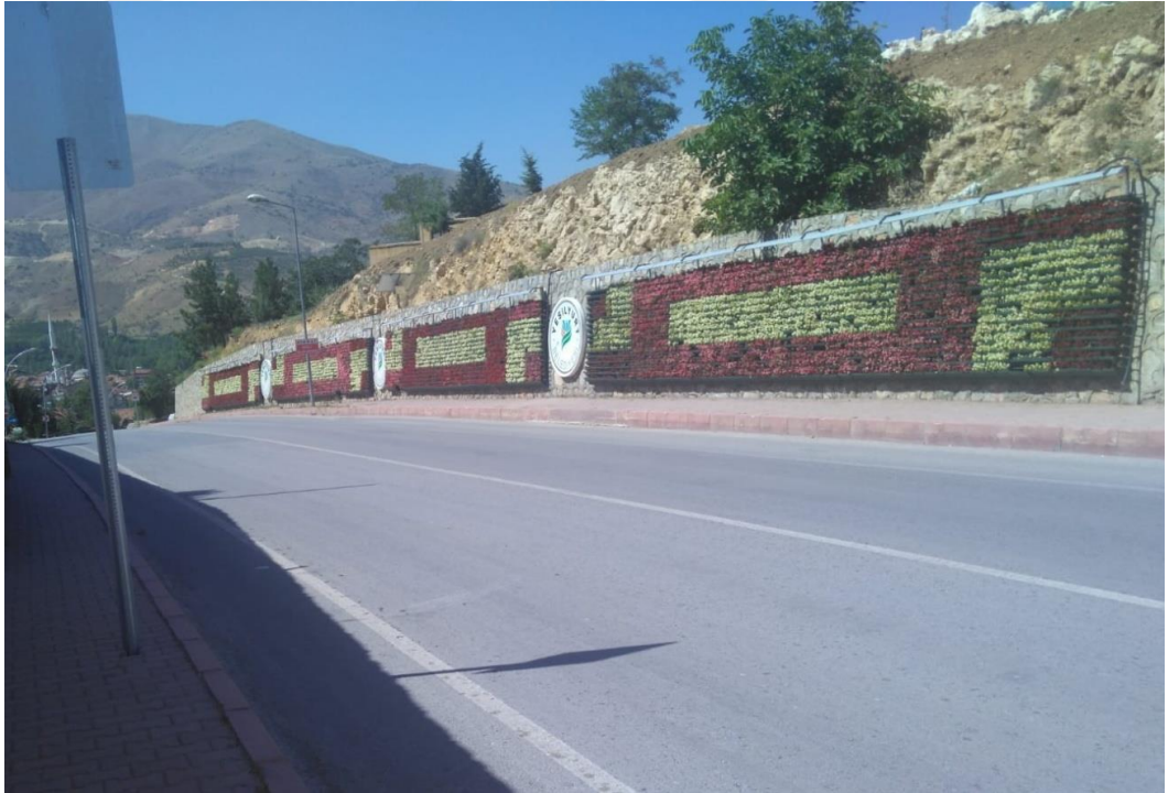
Şekil 5.10. Gedik Mahallesi Çırmıktı yolu dikey bahçe uygulaması
