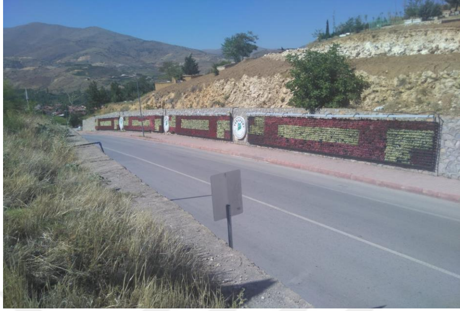
Şekil 5.9. Gedik Mahallesi Çırmıktı yolu dikey bahçe uygulaması
