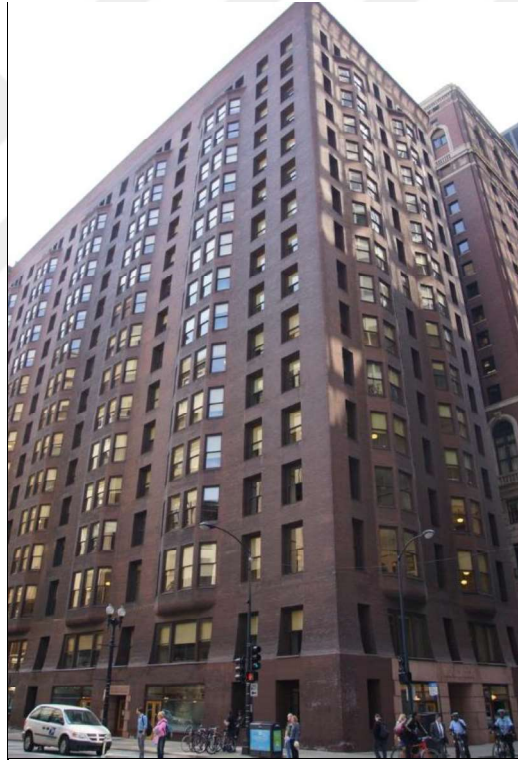
Şekil 2.3: 1891, Chicago, Monadnock binası.
