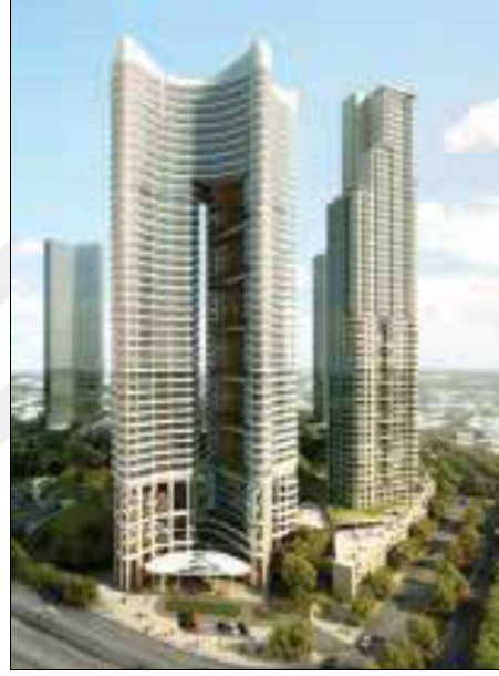
Şekil 2.25: Rüzgâr testi yapılan yüksek yapı örneği.
