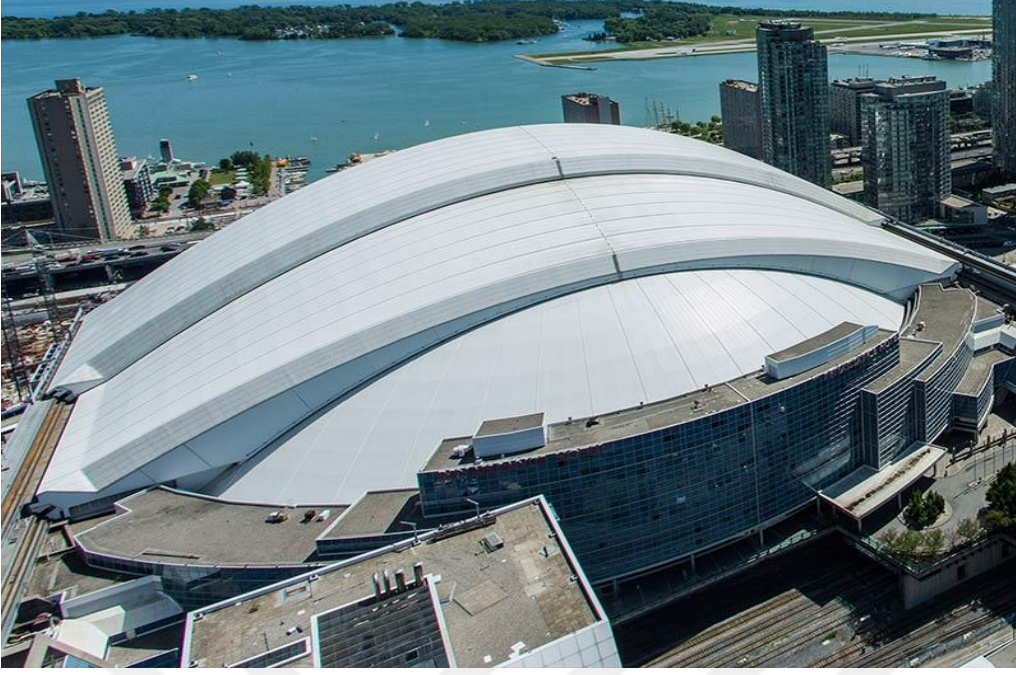
Şekil 2.8 : Toronto Skydome'un kapalı hali, Toronto, Kanada, 1989 (URL-9).
