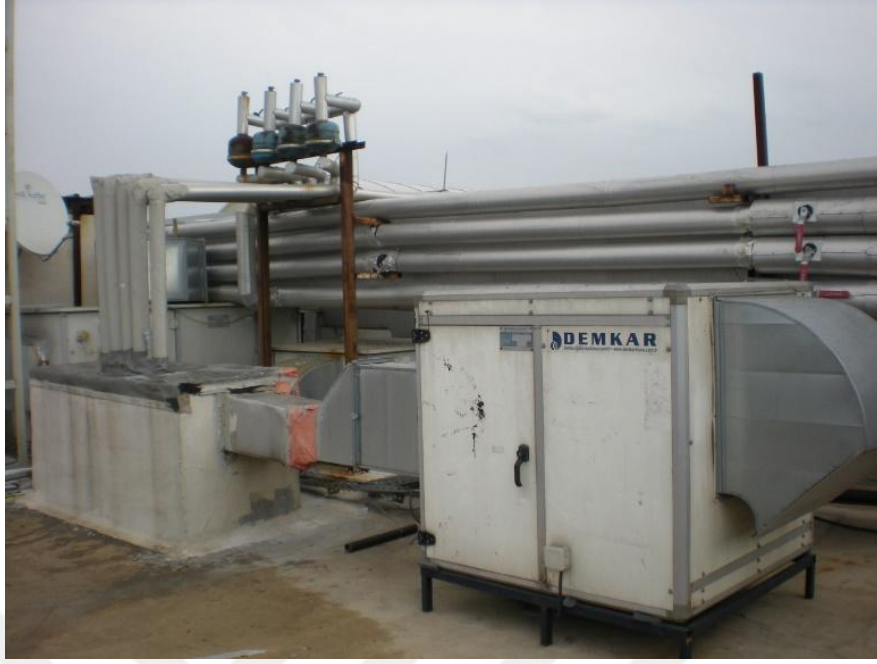
Şekil 3.23. Yemekhane aspiratörü cihazı.
