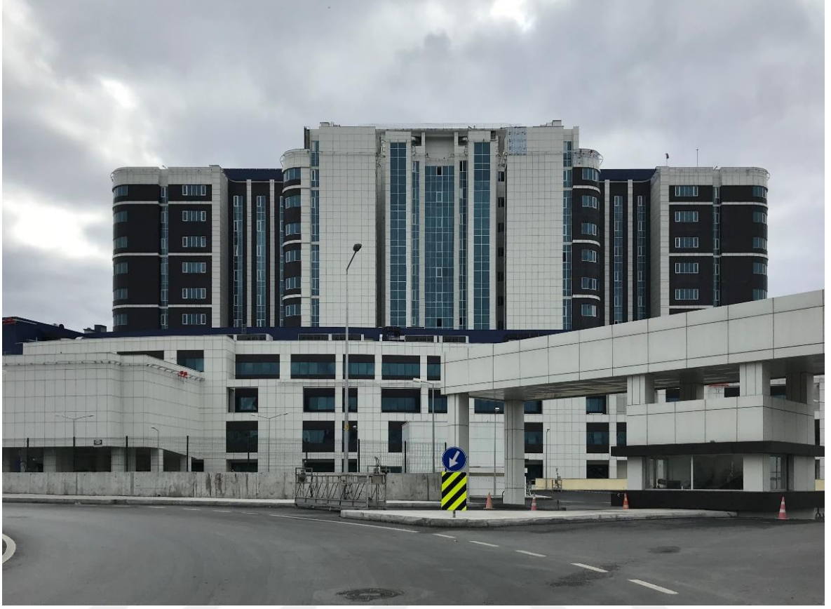
Şekil 51: Seyrantepe Devlet Hastanesi Binası (2020).
