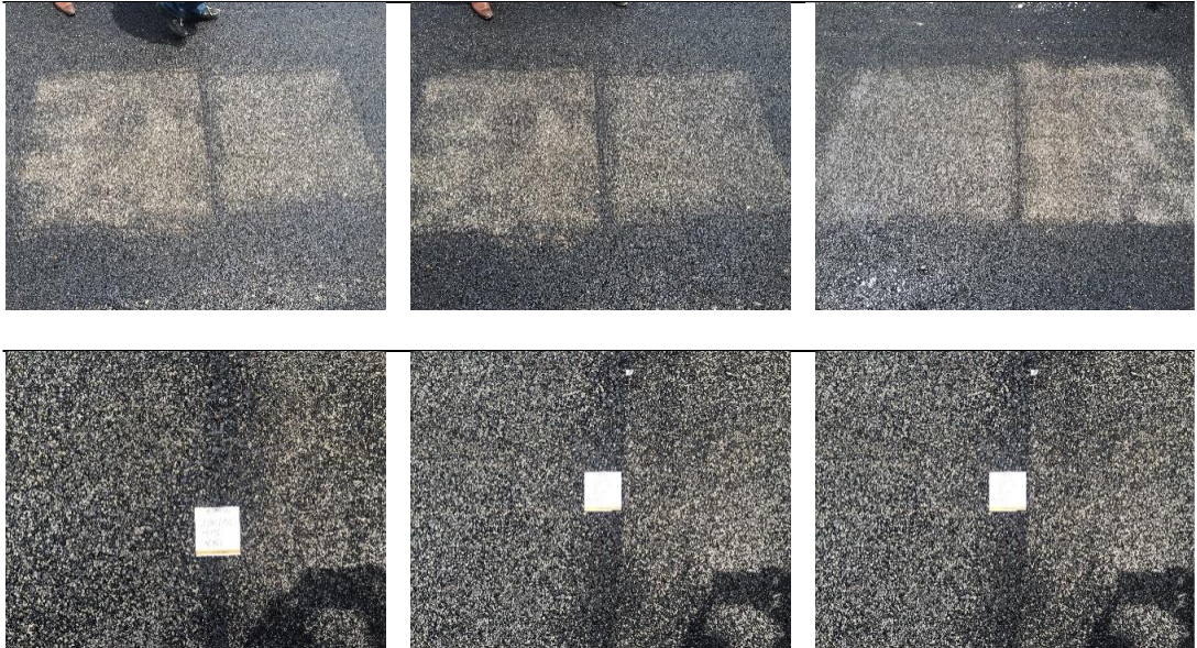
Şekil 3.6. BSK üzerinde pürüzlendirme uygulaması görselleri
