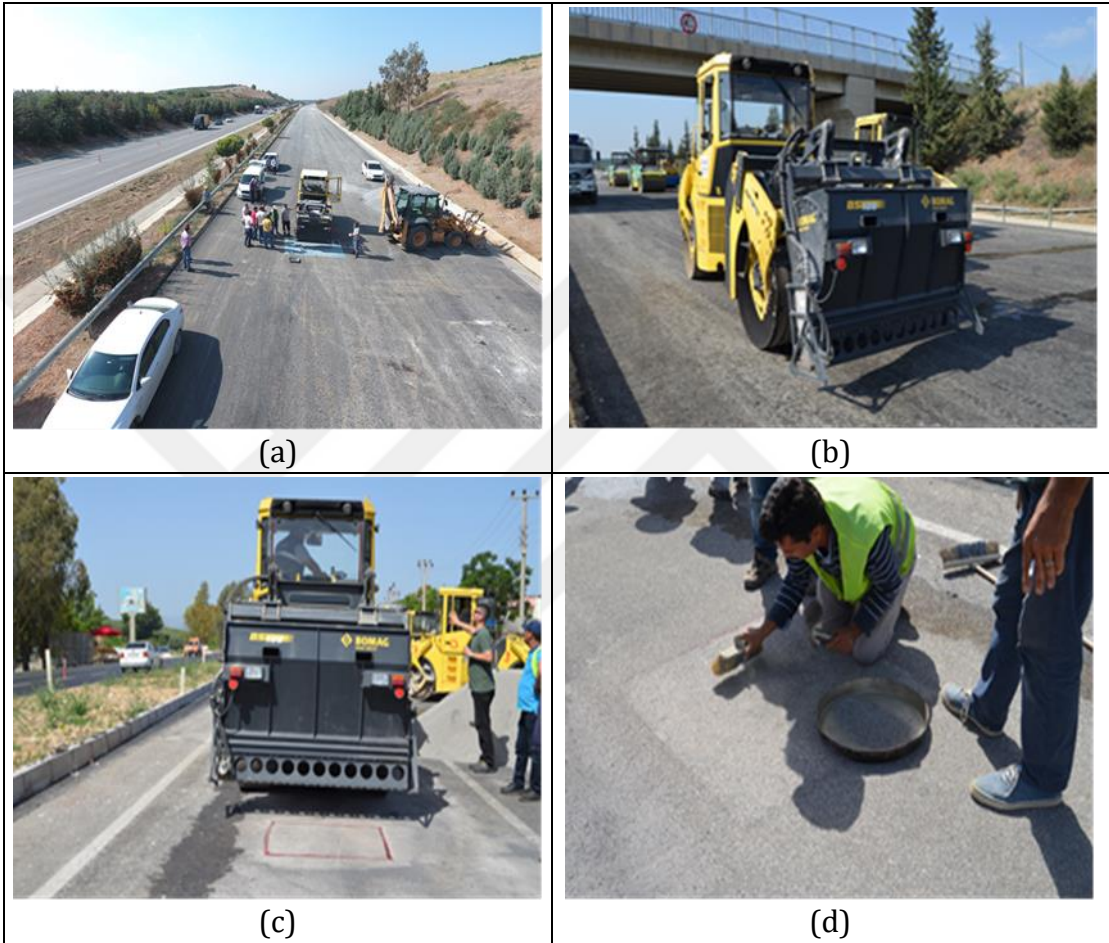
Şekil 3.9. TMA (a,b) ve aşınma (c,d) sahasında serici ayarı
