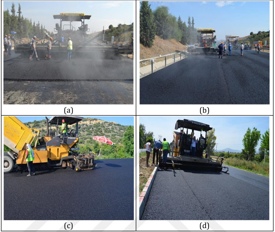
Şekil 3.10. TMA (a, b) ve aşınma (c, d) tabakası inşaatından resimler
