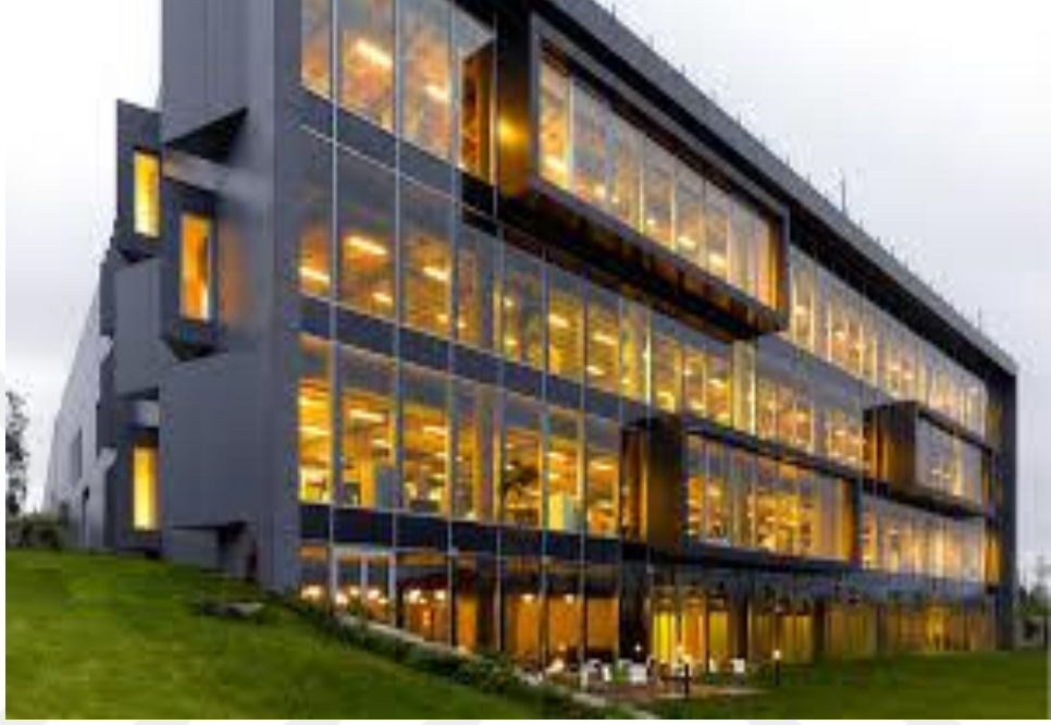
Şekil 4.8: Türkcell Arge Binası
