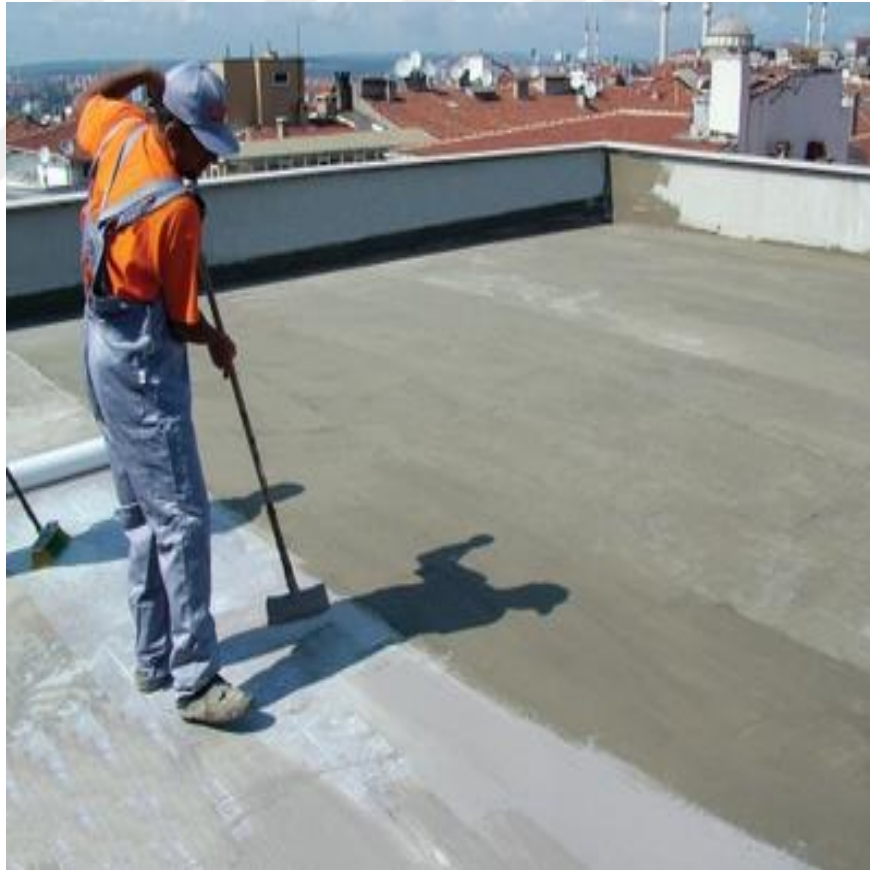
Şekil 3.6: Su Yalıtımı Yapılmadan Önceki Yüzey Hazırlığı
