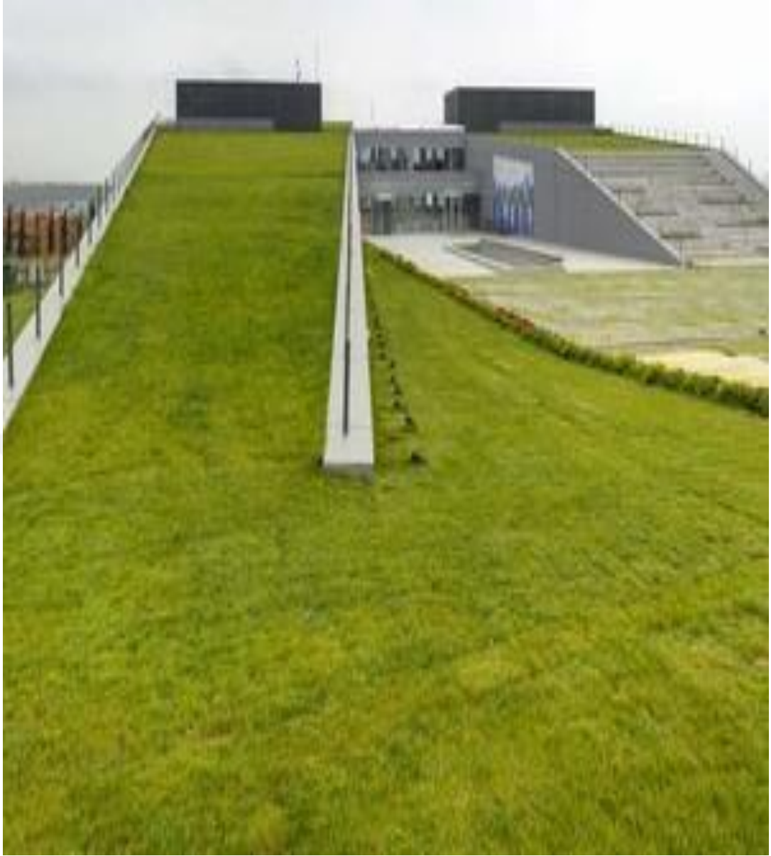
Şekil 4.9: Türkcell Arge Binası Çatısı
