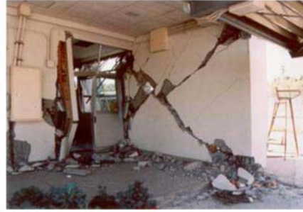
Şekil 5. Yukarıdan aşağıya sırasıyla III., IV. ve V. sınıf hasarlara yönelik bazı örnekler
