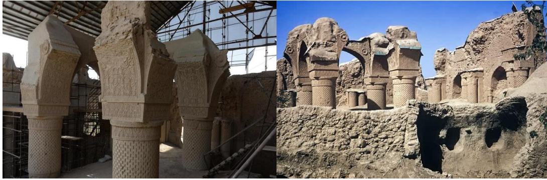
Fotoğraf 3.12. Dokuz Kubbeli Mescit'in Restorasyon Öncesi Durumu. 30
