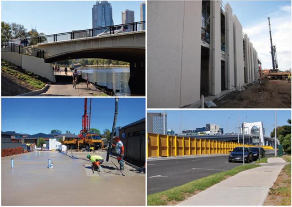
Şekil 11. E-Crete kullanılarak tamamlanan projeler (Provis and Bernal 2014).
