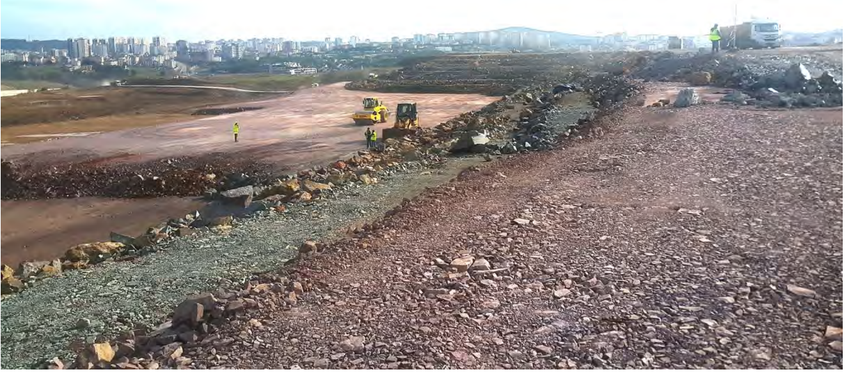
Şekil 4.96: Çalışma alanında kaya dolgu çalışmalarından bir görünüm.
