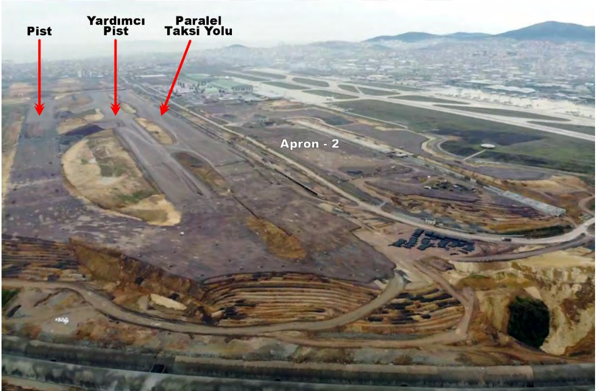
Şekil 4.97: Çalışma alanı batı kesiminde kaya dolgu çalışmalarından bir görünüm (Bakış yönü batı).
