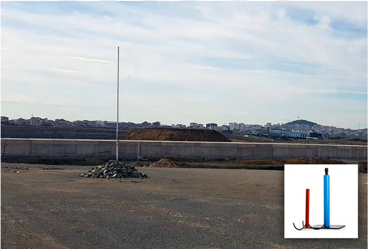
Şekil 4.99: Çalışma alanında oluşturulan oturma kolonundan bir görünüm.
