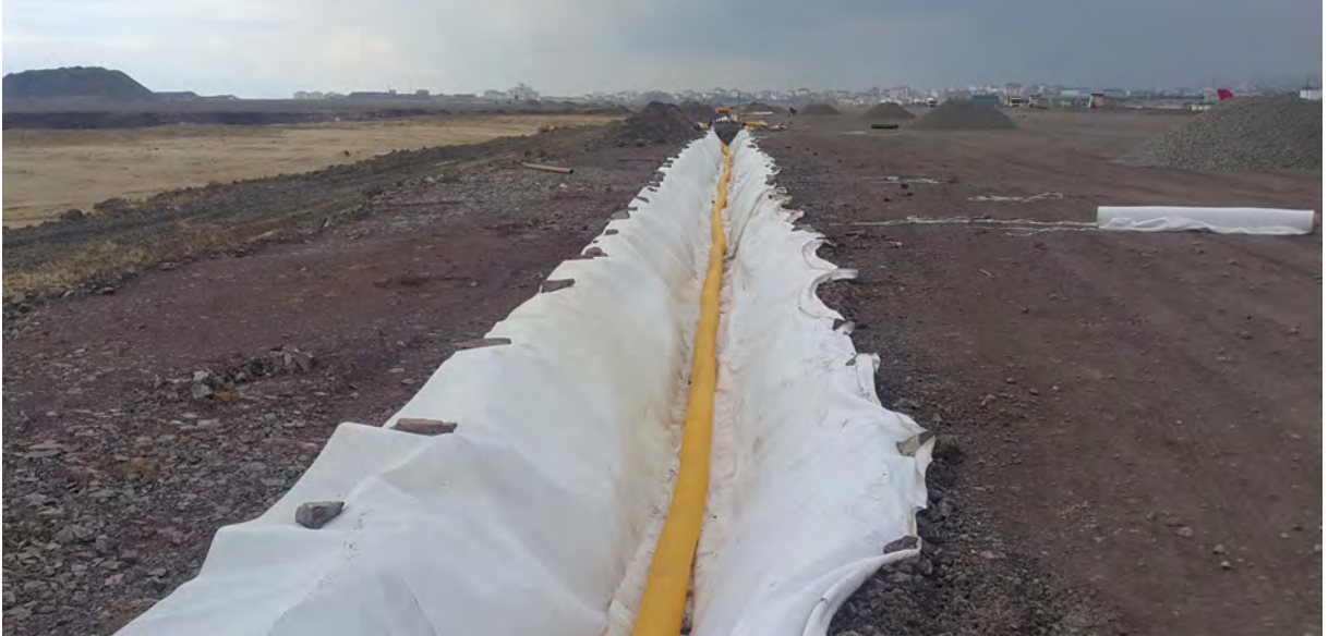
Şekil 4.5: Kaplamalı yüzey çevresi drenaj hattı imalatından bir görünüm.
