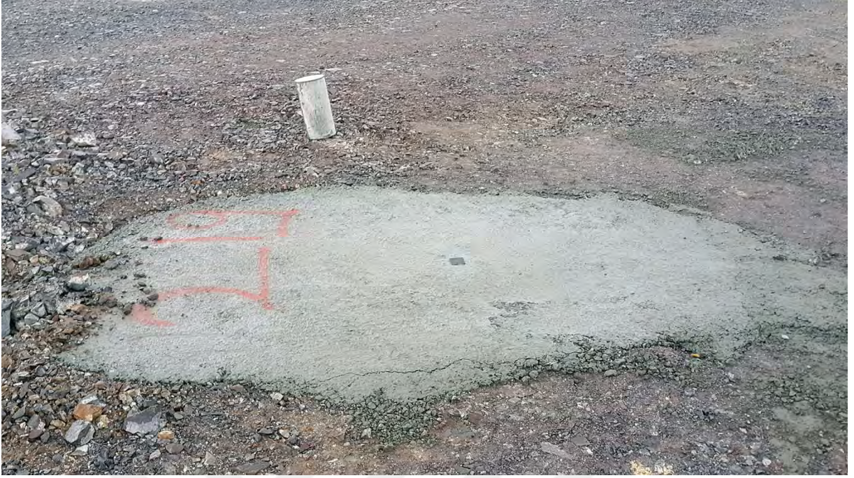
Şekil 4.100: Çalışma alanında oluşturulan oturma plakasından bir görünüm.
