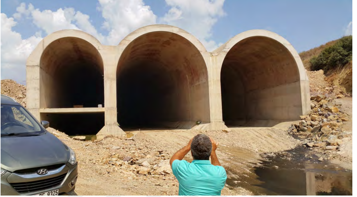
Şekil 4.9: Kemiklidere derivasyon tüneli kesitinden bir görünüm.
