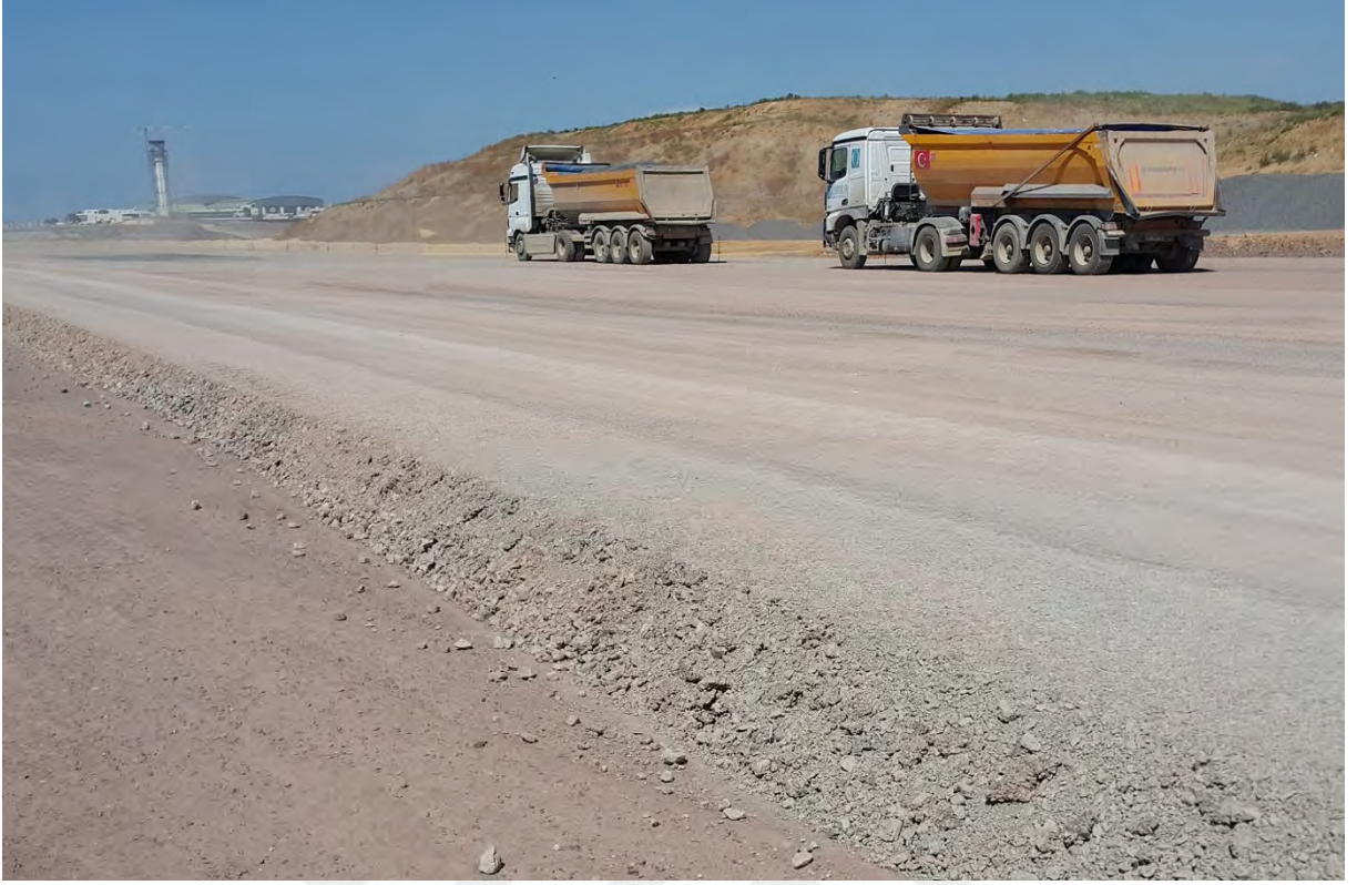
Şekil 4.98: Çalışma alanında kırmataş temel tabakasından bir görünüm.
