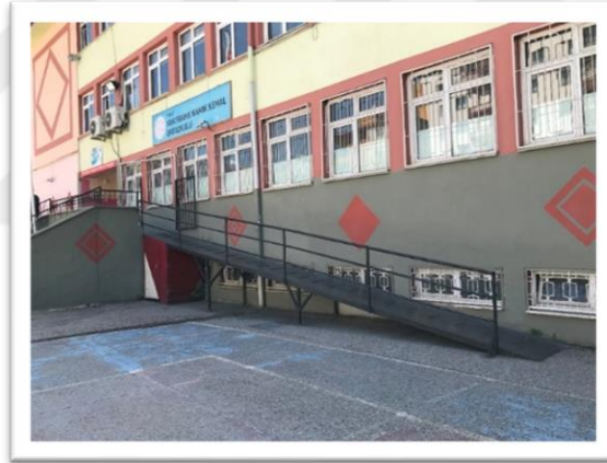
Şekil 4.60. Tokat Vakıfbank Namık Kemal Ortaokulu bina girişi
